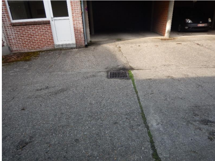
Fig. 12: de op te breken verharding aan Kol. Aertsplein 11 met centraal een afvoerput
