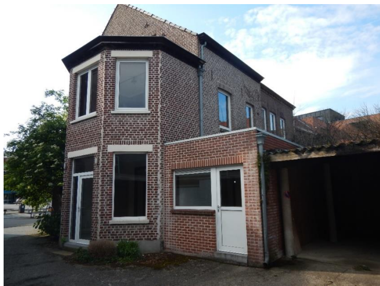
Fig. 16: de achtergevels van de af te breken panden.
