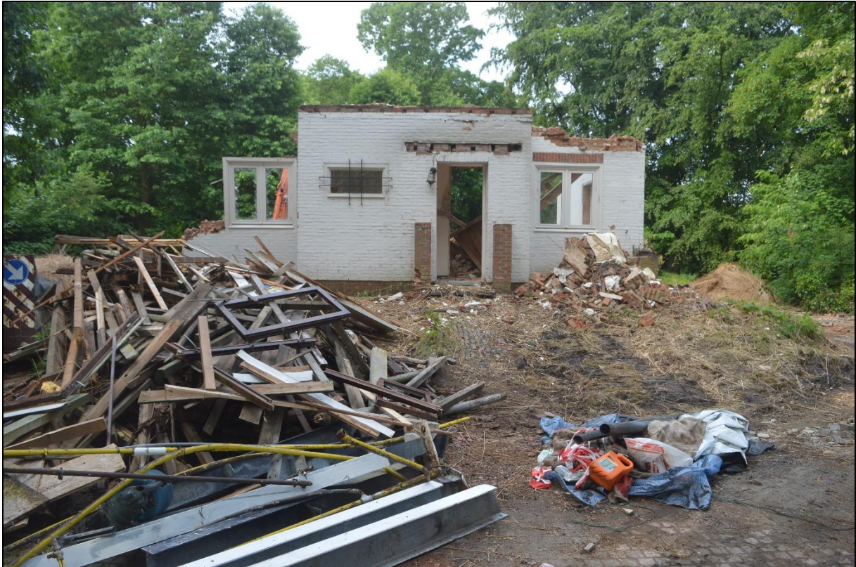
Afb. 13: Deels afgebroken huis op het onderzoeksterrein (Bron: Aron bvba, dd. 24/05/2018, 2018E221).
