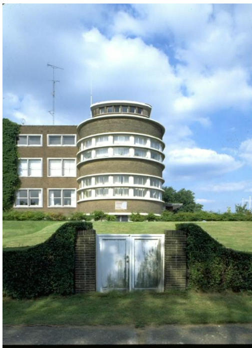
Afb. 52. Schoolgebouw van de Hogere Zeevaartschaal.
