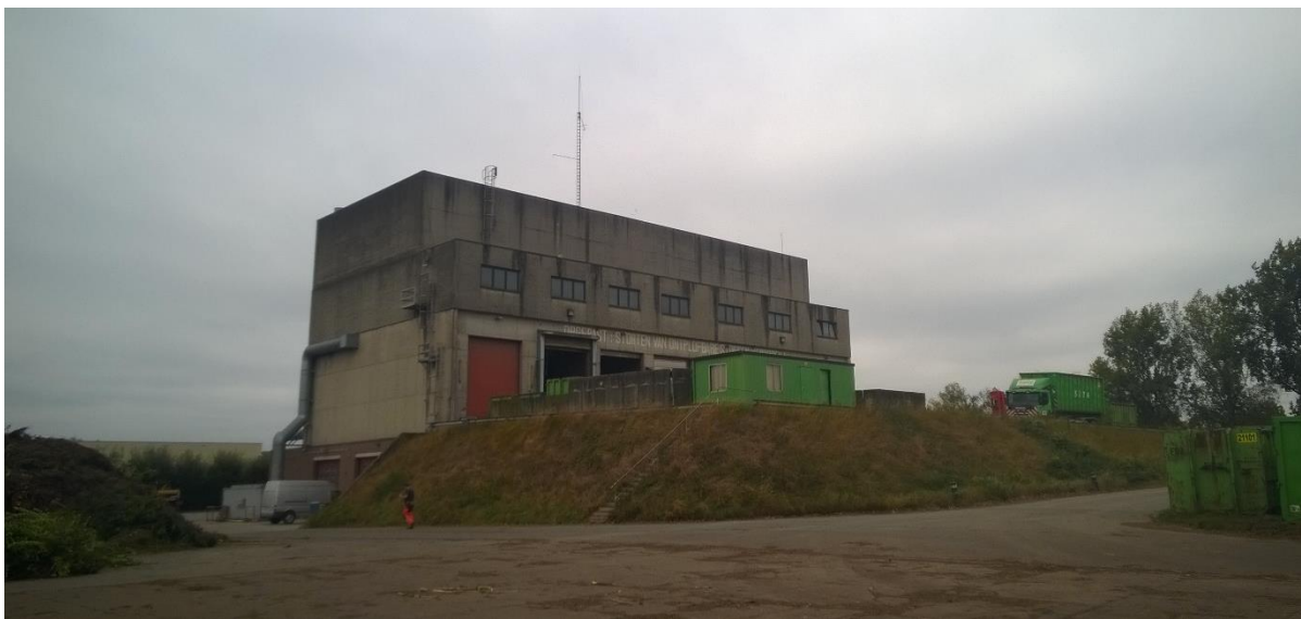
Figuur 9: Bunkergebouw, hier zal een oprit naar de talud voorzien worden.
