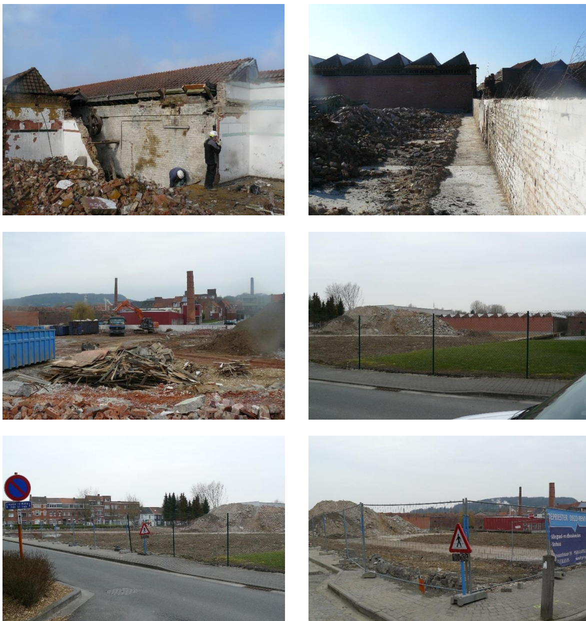
Figuur 4: Foto's van het plangebied tijdens en na de afbraak van de textielfabriek 'Cyr Cambier' 9
