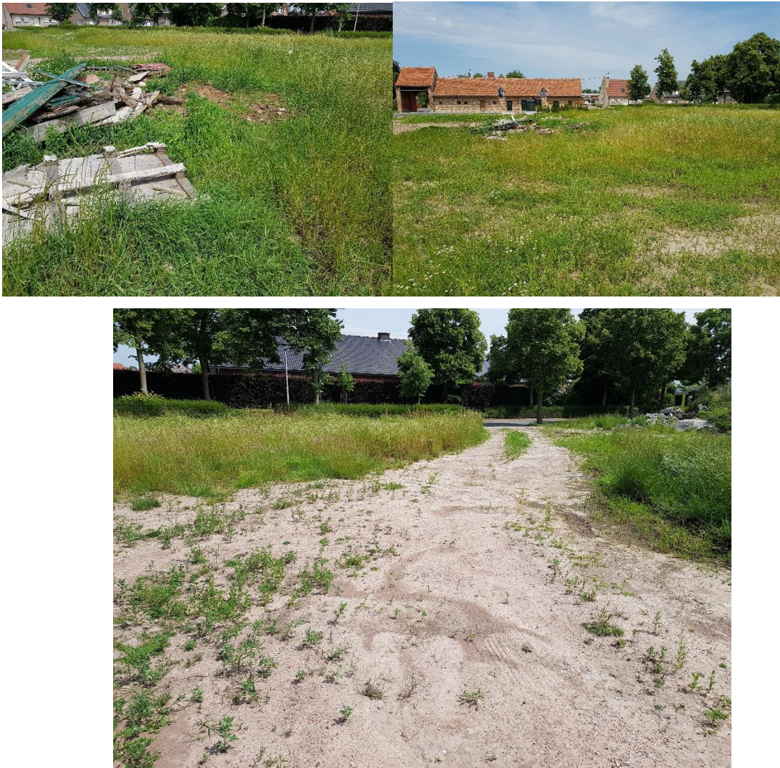
Figuur 22. Impressie recente sloopwerken
