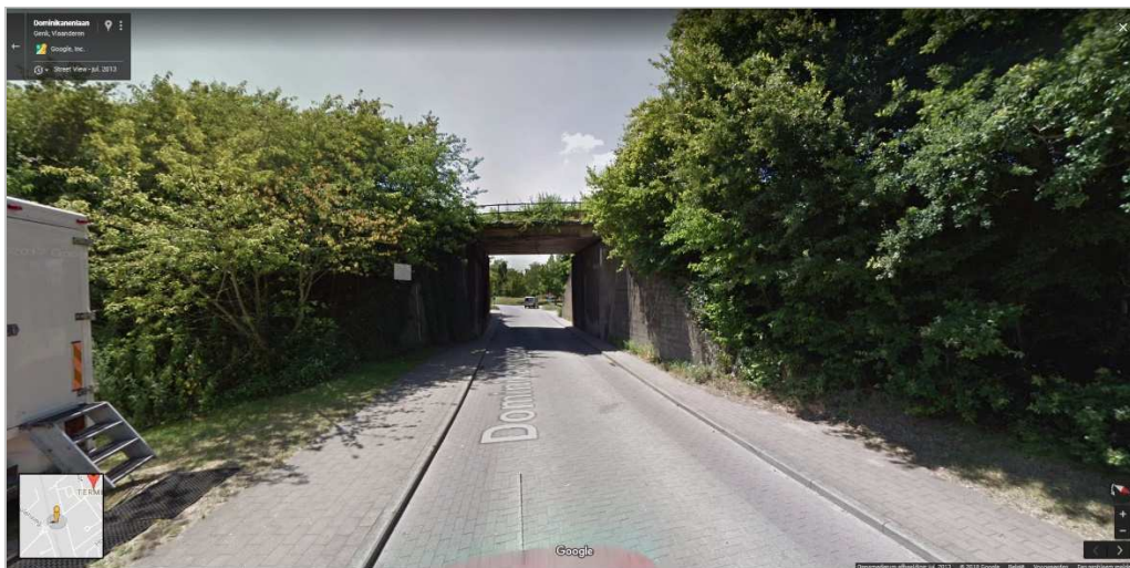
Figuur 4: Zicht op spoorwegbrug over Dominikanenlaan (Google Street View, juli 2013)
