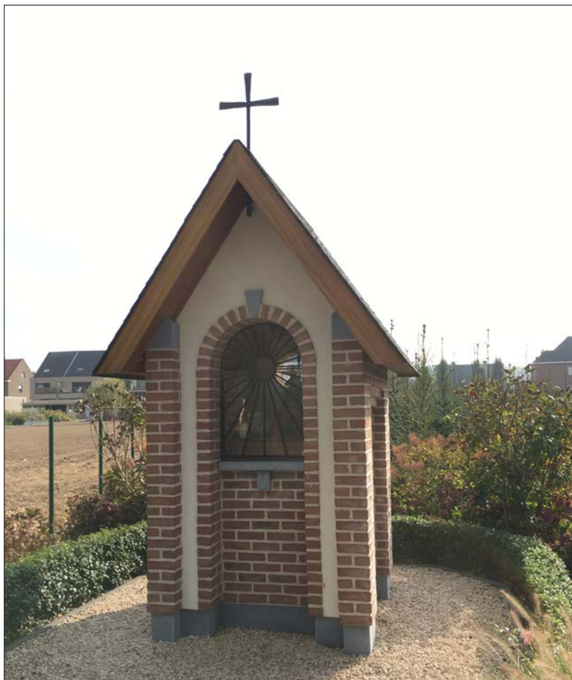
Figuur 10: Foto 3 van de terreininspectie met zicht op de kapel
