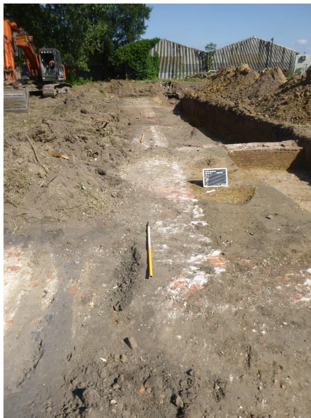
Figuur 32: Oostelijk zicht op noordelijke hofmuur S4.5 die slechts oppervlakkig werd vrijgelegd (ABO nv, 2018)
