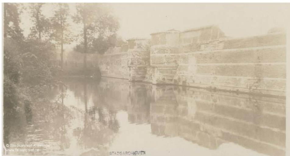
Figuur 28: Zicht op westelijke hofmuur met natuurstenen speklagen tussen de baksteenlagen (Goovaerts 2017)
