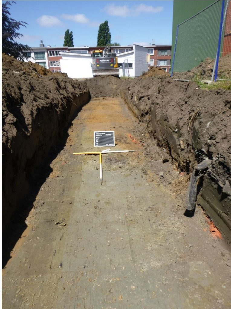
Figuur 49: Recente verstoring in de vorm van riolering(ssleuven) thv WP5 (ABO nv, 2018)
