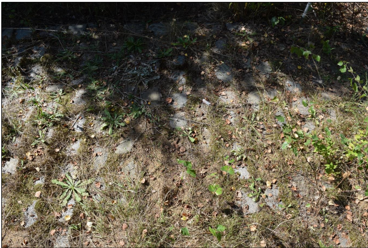
FOTO 5: Zicht op de kasseien van de zuidwestelijke inrit op het onderzoeksterrein. Deze inrit is volledig verhard. (Aron bvba, dd. 08/09/2016, 2016H93)
