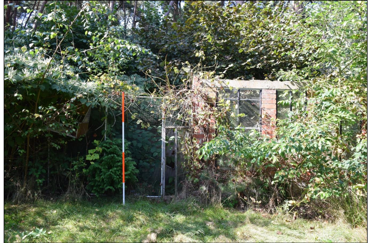
FOTO 30: Zicht op bestaande bebouwing (vermoedelijk restanten van een serre / volière) centraal op het onderzoeksterrein. Foto genomen vanuit het zuidoosten (Aron bvba, dd. 08/09/2016, 2016H93)
