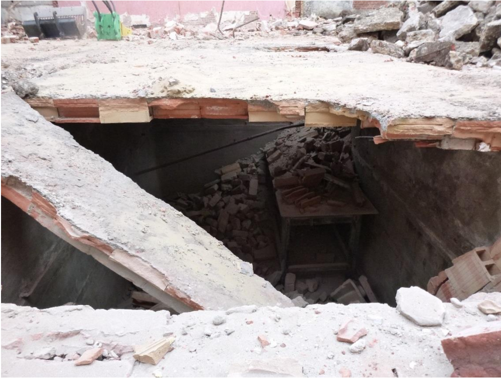
Figuur 11: Zicht in de kelder
