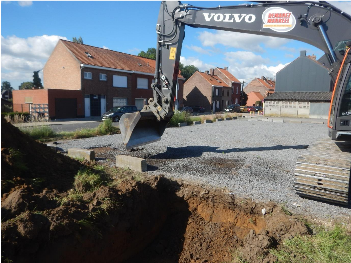
Figuur 35: Zicht op de verharding en het voorzichtig verwijderen ervan.
