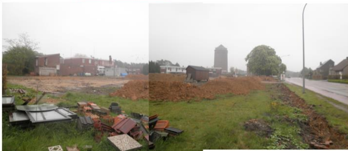
Afbeelding 17: Het verwijderen van het de verharding in 2012, (bron: opdrachtgever).
