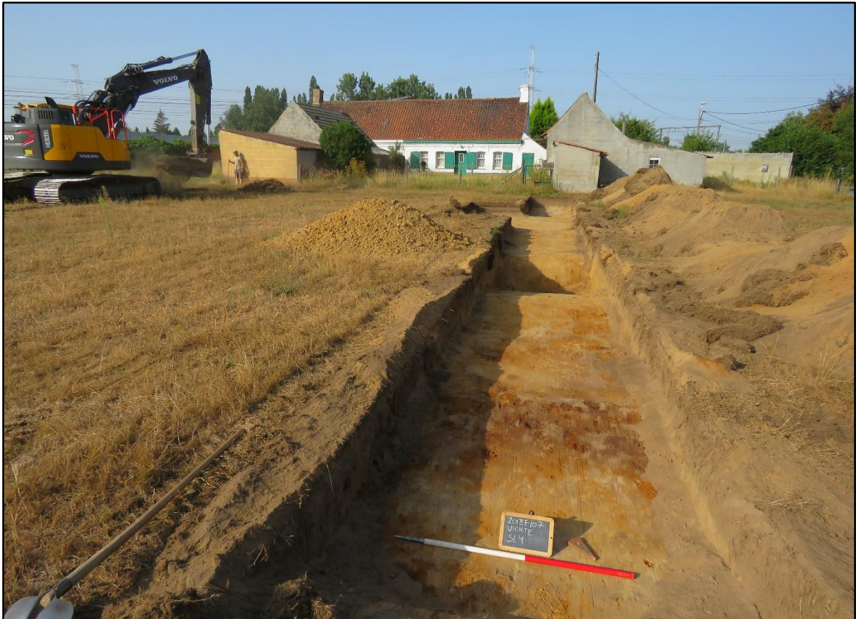
Figuur 8 Sfeerbeeld van sleuf 4 met centraal profielput, achteraan een kijkvenster en de boerderij.
