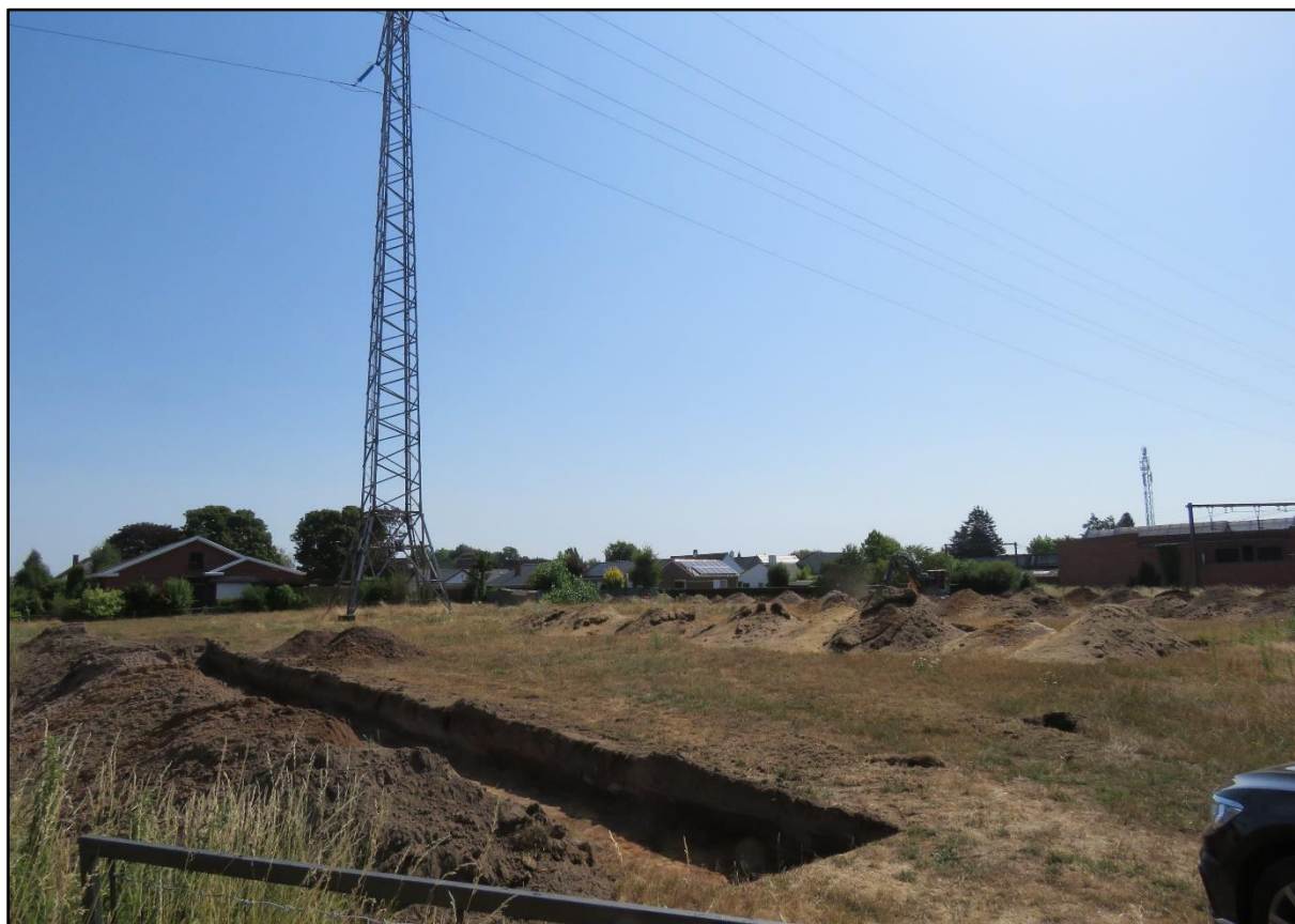
Figuur 7 Zicht op de sleuven vanuit het noordwesten.
