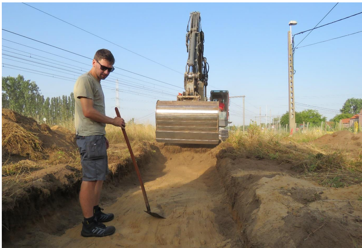
Figuur 6 Sfeerbeeld tijdens de aanleg van de sleuven, vlak aan de spoorlijn.
