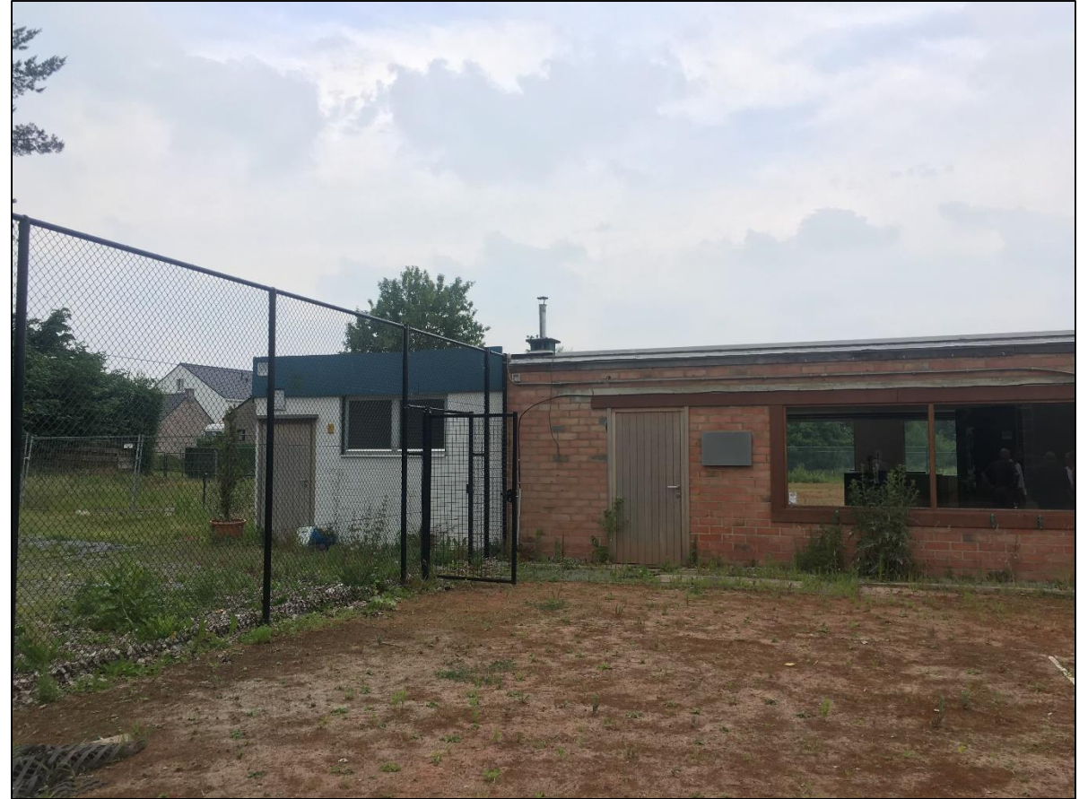
Foto 3: Zicht op de cafetaria, foto genomen vanuit het zuiden (Bron: initiatiefnemer, dd 29/05/2018, 2018H145).
