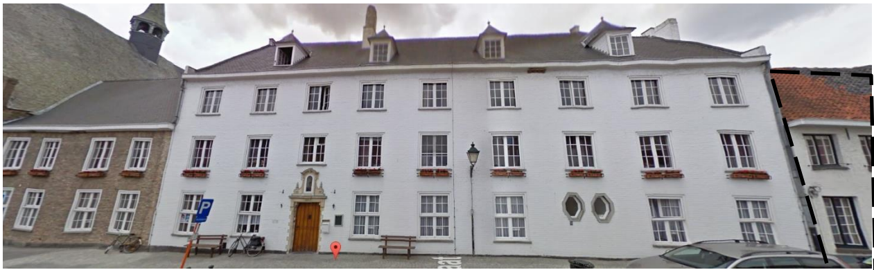
Figuur 2a: Zicht op de te slopen volumes ten noorden van het hospitaalvolume, zijde Kerkstraat. Het hoekhuis blijft particulier bezit en maakt geen deel uit van het plangebied (bron: Google Street view)
