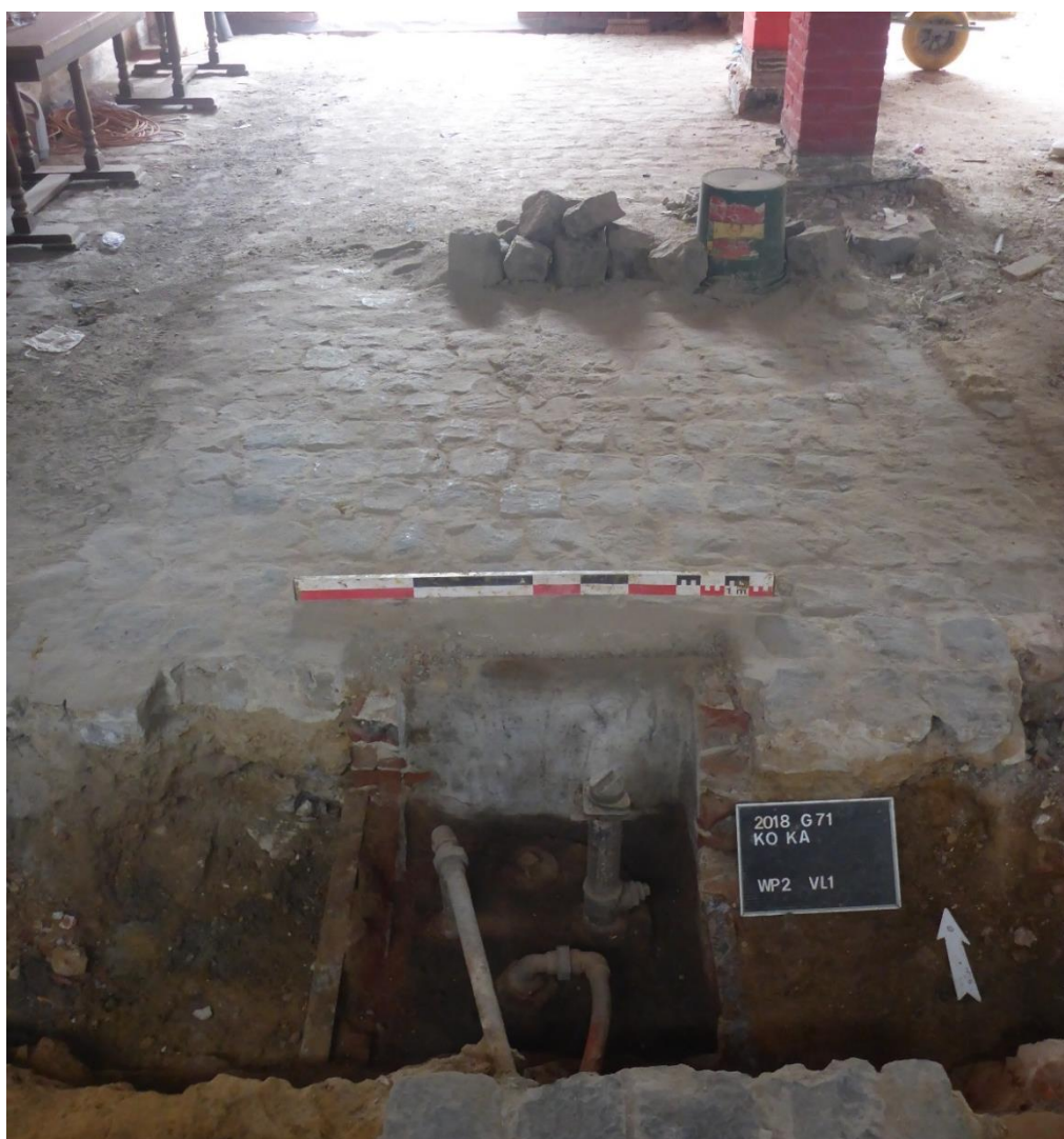
Figuur 20 en 20 bis: werkfoto's van proefput 2, vlak 1, met de mazouttank onder de bestrating.
