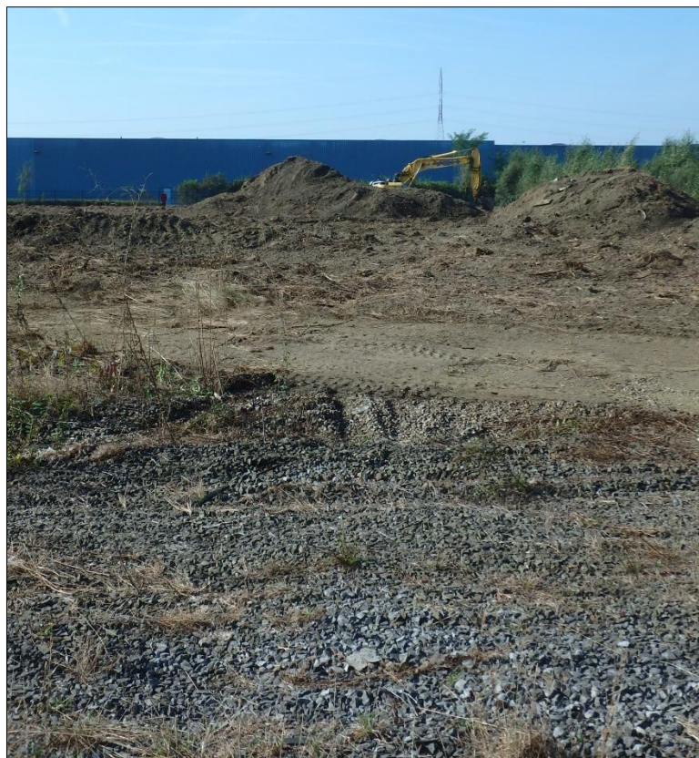
Figuur 6: Terreininspectie (ARCHEBO bvba, 2016).
