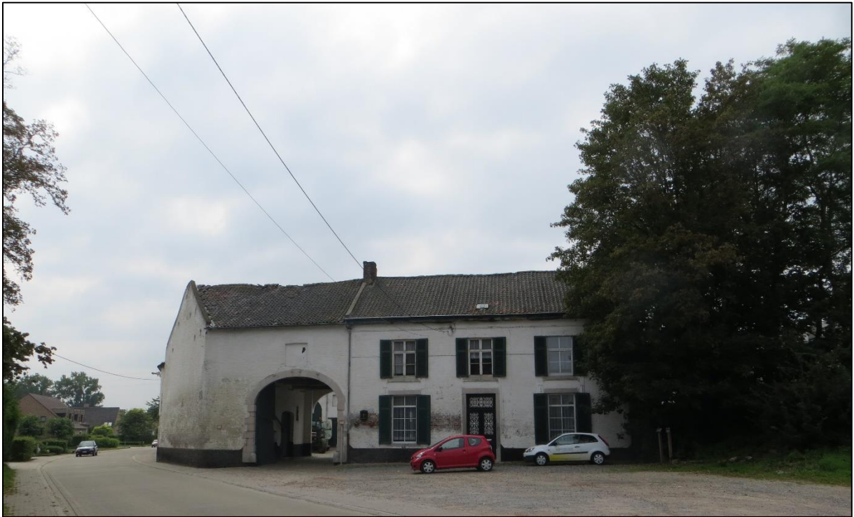
Afb. 5: Foto van hoeve Brone met vooraan de oostelijke verharde parking en links de Koninksemstraat. Foto genomen vanuit het noordoosten (Bron: Architectenbureau Michel Janssen, dd 04/09/2014, 2018G147).
