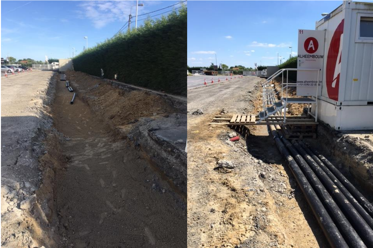
Foto 2: Opbraak van de parking en verstoring van de bodem voor de aanleg van de middenspanningskabels. (©Agristo juni-juli 2017)
