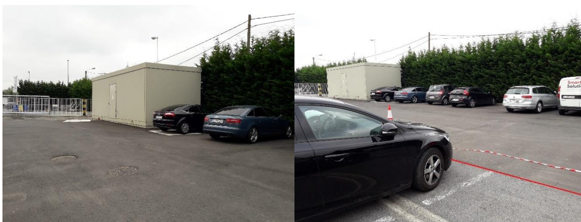
Foto 1: Links: Nieuwe elektriciteitskabine met voorliggende nieuwe asfalt, Rechts: duidelijke grens nieuw asfalt/oud asfalt ter hoogte van de parking. (@BAAC Vlaanderen bvba 12-07-2018)
