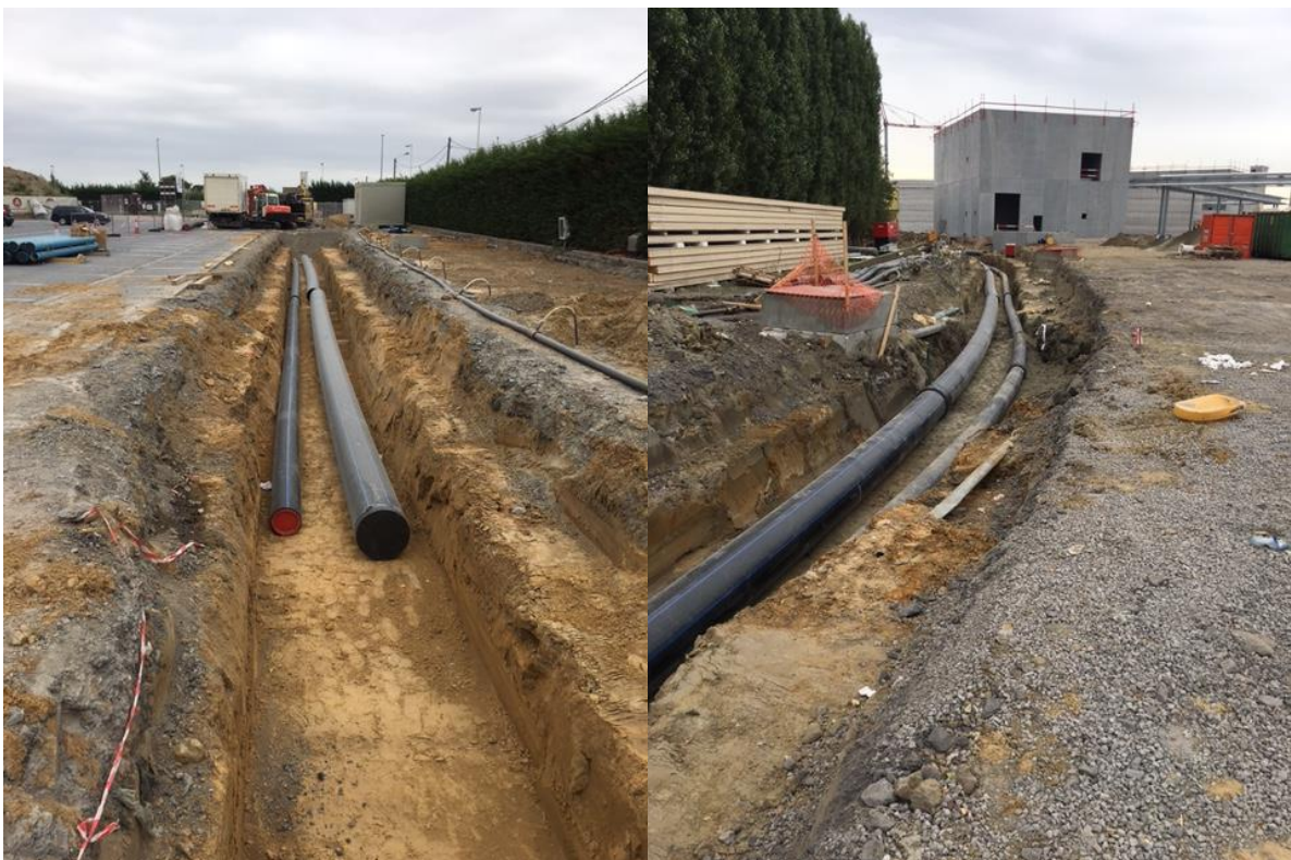
Foto 3: Opbraak van de parking en verstoring van de bodem voor de verlegging van de waterleiding. (©Agristo juni-juli 2017)
