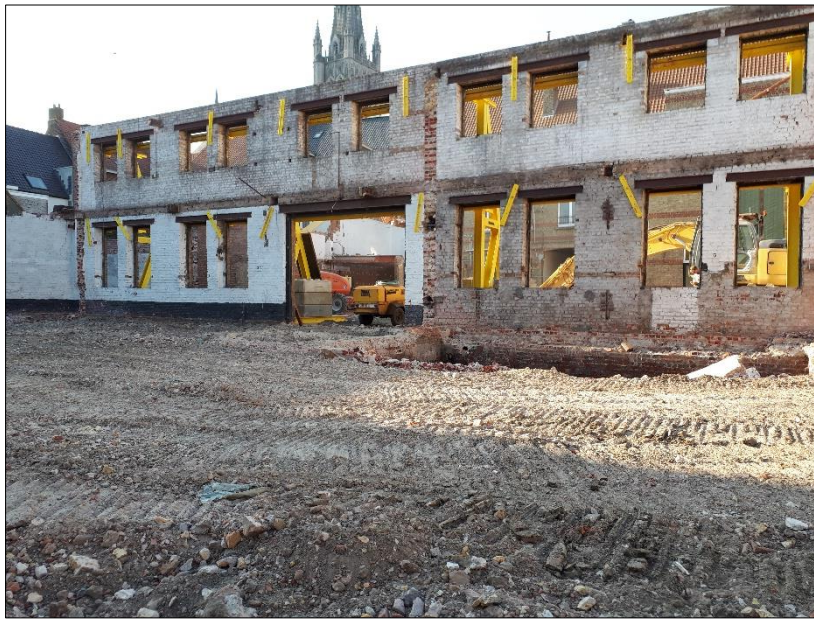
Figuur 6. Te behouden gevel centraal op het projectgebied, geschoord aan zuidelijke zijde
