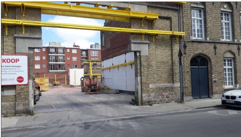
Figuur 4. Zicht op het projectgebied vanaf de Elverdingestraat en de te behouden voorgevel
