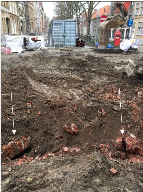
Figuur 25. Bij rioleringswerken kwam in maart 2018 de overwelfing van de Ieperlee aan het licht ter hoogte van Veemarkt nr. 1 (met dank aan J. Allemon)
