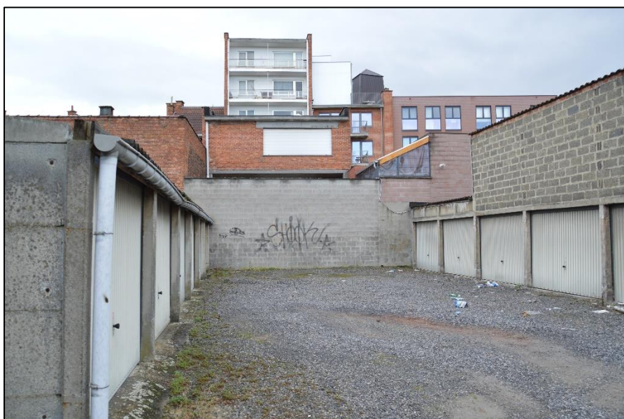
Afb. 9: Zicht op het achterliggende terrein met aanwezigheid van meerdere garageboxen, zicht vanuit het noorden (foto initiatiefnemer, dd. 2018)
