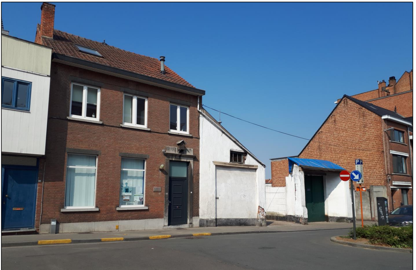
Afb. 4: Zicht op de gevel, Vanden Tymplestraat 15, uit ZO
