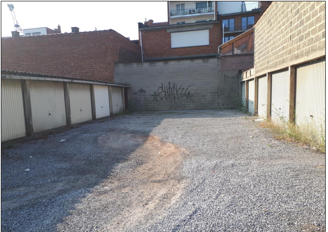
Afb. 7: Zicht op het achterliggende parkeerterrein, uit N.
