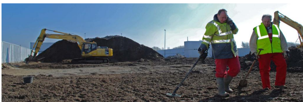
Figuur 23 : Detectie door middel van metaaldetector (archief Bom-Be)
