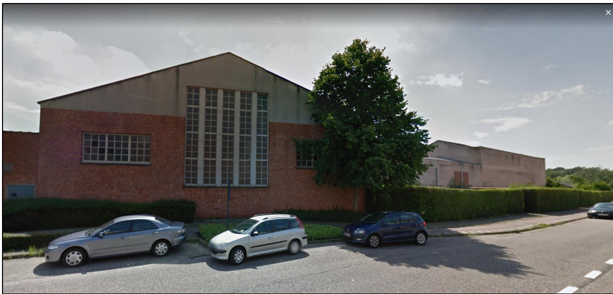
Figuur 4: zicht op de fabrieksgebouwen vanaf de Fort V-sstraat (Geopunt 2018)
