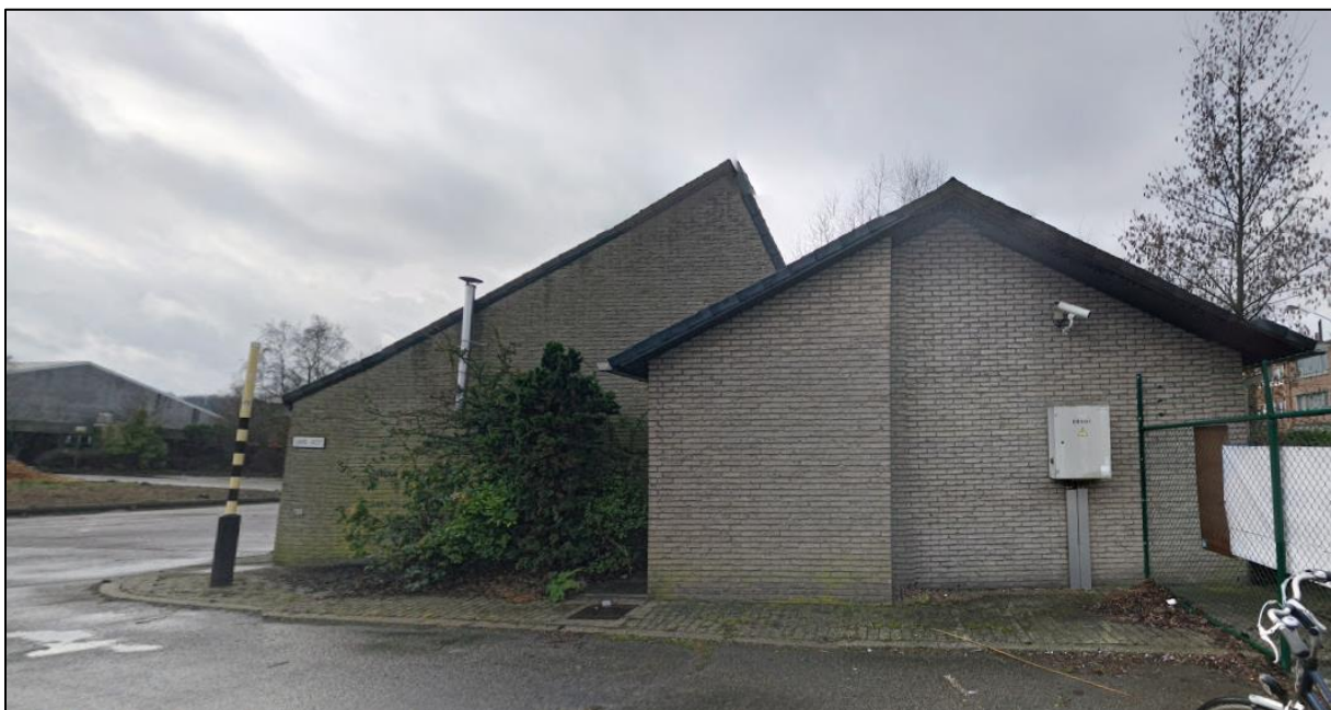
Figuur 5: Zicht op de conciërgewoning (rechterzijde vanaf de ingang langs de Fort V-sstraat) (Geopunt 2018)
