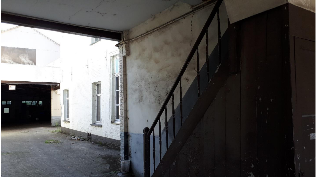
Figuur 7 bestaande toestand: poortdoorgang
