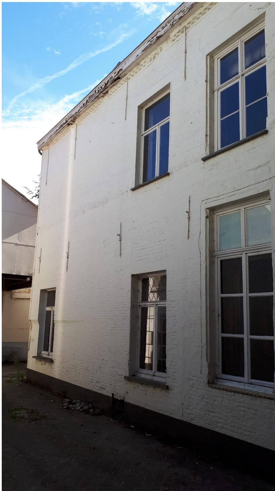
Figuur 9 bestaand toestand zijgevel achterbouw
