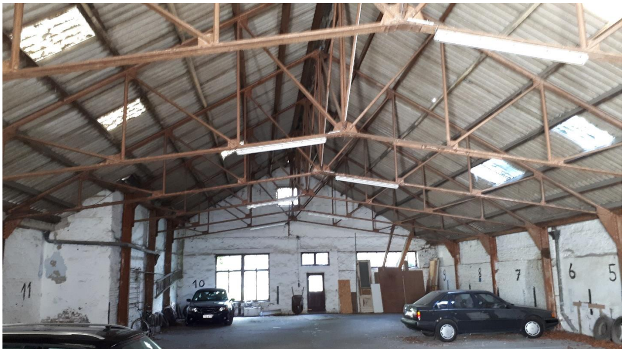
Figuur 11 bestaande toestand: loods ingericht als parkeergarage
