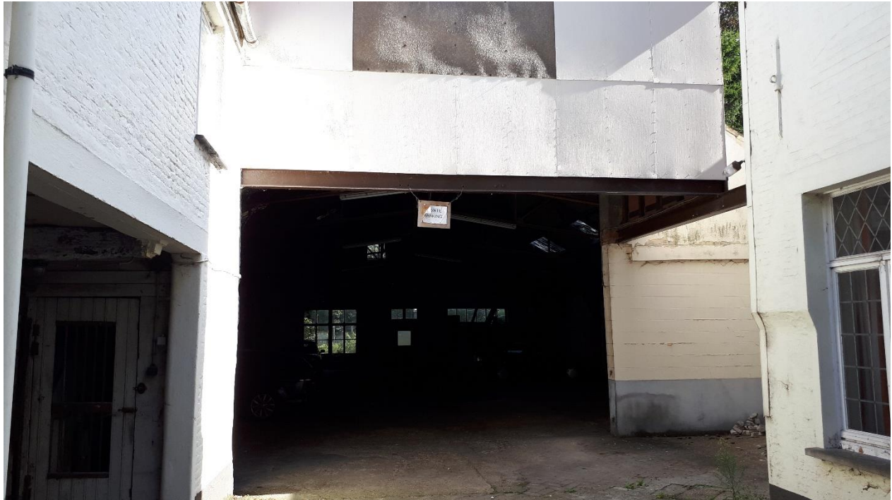
Figuur 10 bestaande toestand: toegang tot de loods
