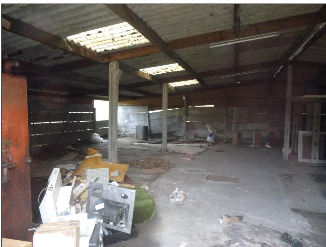
Figuur 5: Hangar bij huis nr. 13 (ABO nv)
