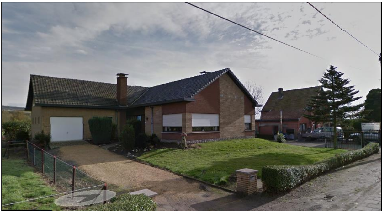
Figuur 15: Huis nr. 11A ingeplant op een aangelegde verhoging (Google Maps 2018)
