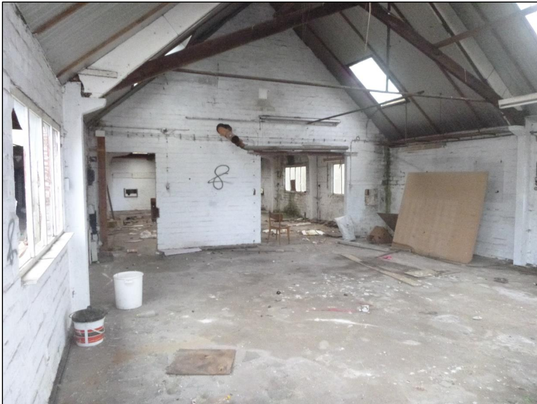
Figuur 6: Loods bij huis nr. 13 (ABO nv)
