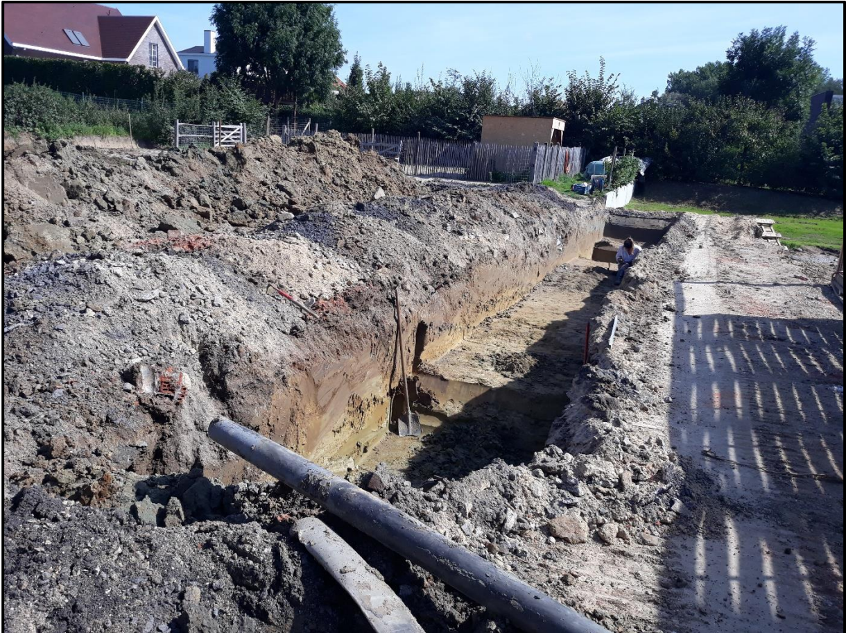
Figuur 6: Zicht vanuit het westen op de getrokken O – W sleuven. Op de foto is sleuf 2 zichtbaar.
