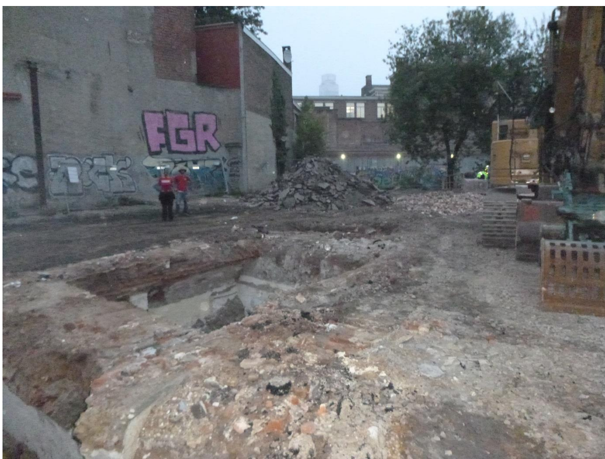
Figuur 5: Foto van het terrein bij aanvang van het onderzoek. In de voorgrond de opengelegde kelder van het pand aan huisnummer 43, dat voor aanvang van de werken gesloopt werd tot op het maaiveld.
