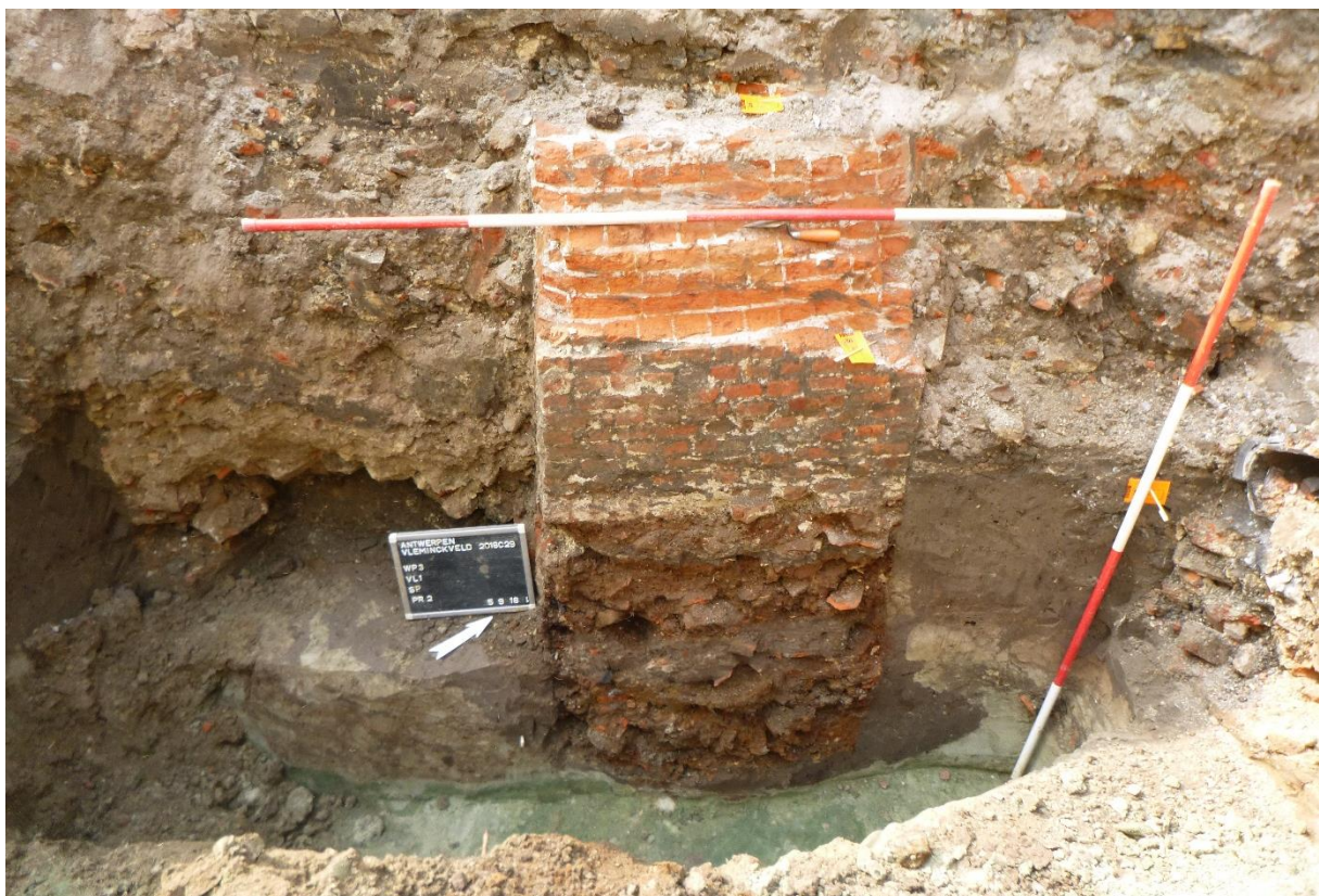
Figuur 17: Profiel 2 in werkput 3
