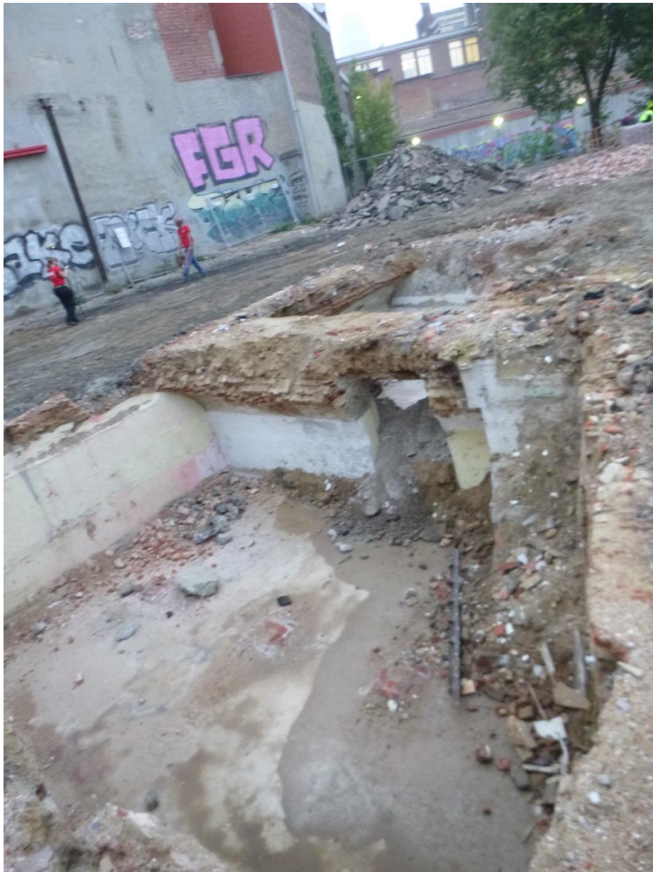
Figuur 11: openliggende kelder aan huisnummer 43 bij aanvang van het proefputtenonderzoek
