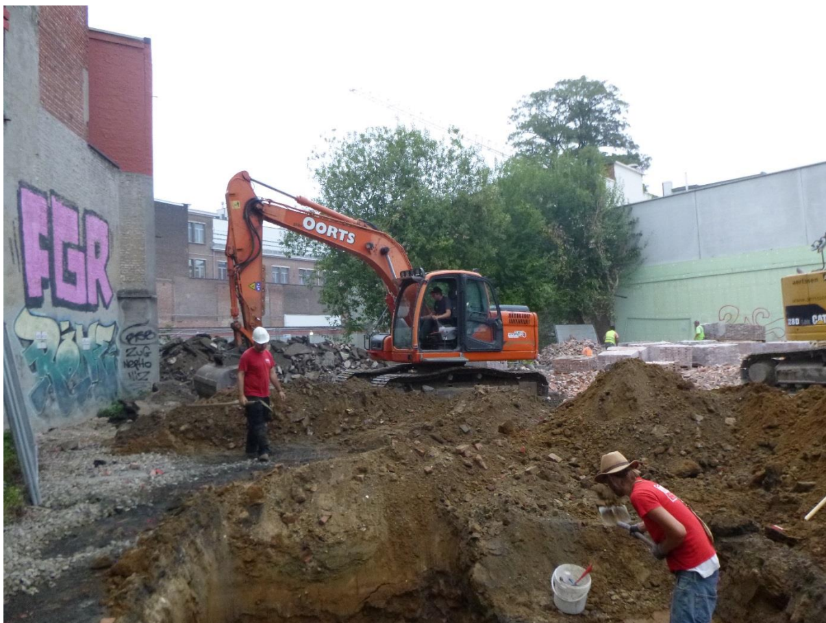
Figuur 7: Sfeerfoto van de werkzaamheden
