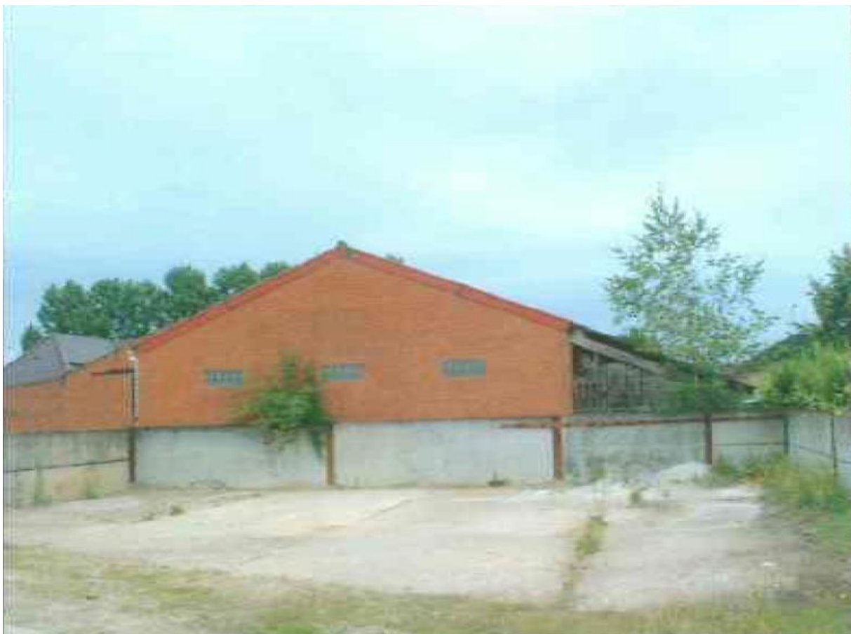
Fig. 11: de betonnen laad- en losvloer aan de loods, bereikbaar (geweest) vanaf de Heirbaan © consoorten Van De Boel
