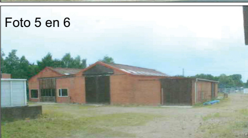
Gesloopte loods vanuit de Rijksweg
