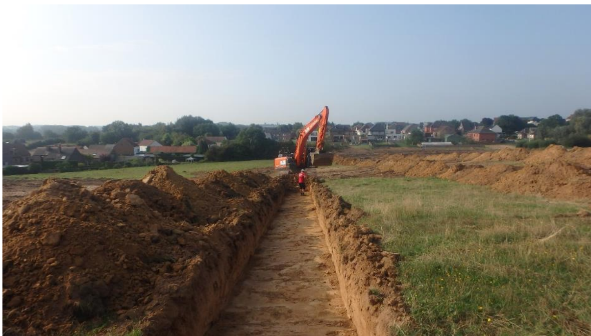
Figuur 8: zicht op het terrein tijdens het graven van de proesleuven, foto vanuit het noorden zichting zuiden. De helling van het terrein is hierop lichtjes zichtbaar
