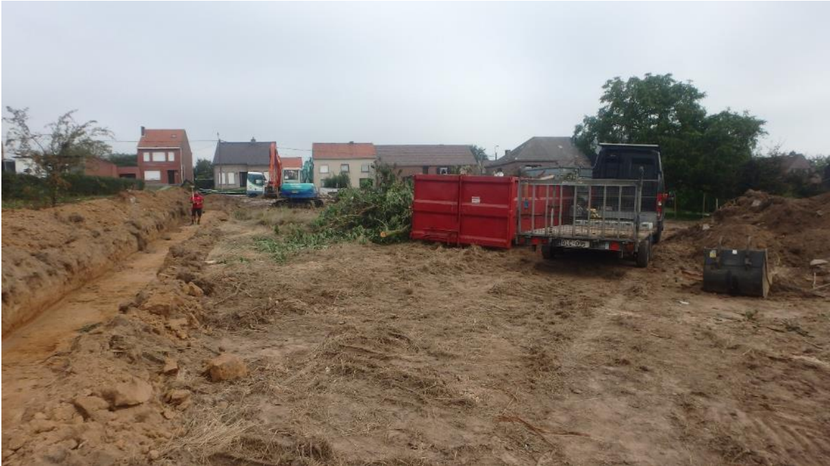
Figuur 9: Graven van de proefsleuven in het meest noordelijk stuk van het terrein, aan de gesloopte woningen aan de Hoogstraat
