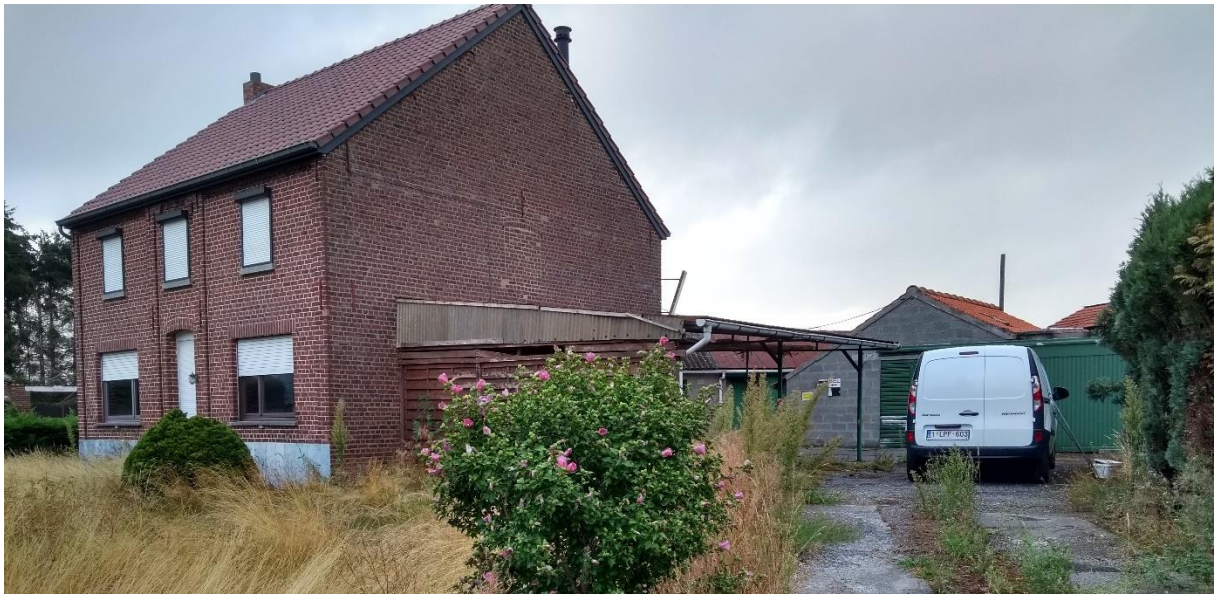
Figuur 31: Zuidoostelijk zicht op het verlaten gebouw met achterligende koterijen. (©BAAC)
