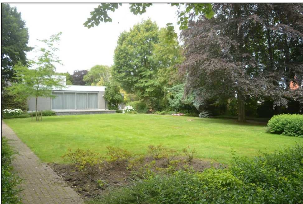
Afb. 30: Zicht op de ambtswoning vanaf oosten (Bron: ARON bvba, dd. 22/06/2018, 2018F213).
