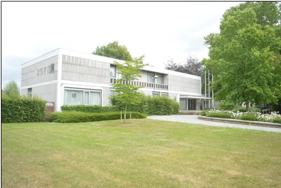
Afb. 29: Zicht op de ambtswoning vanaf het zuidwesten (Bron: ARON bvba, dd. 22/06/2018, 2018F213).
