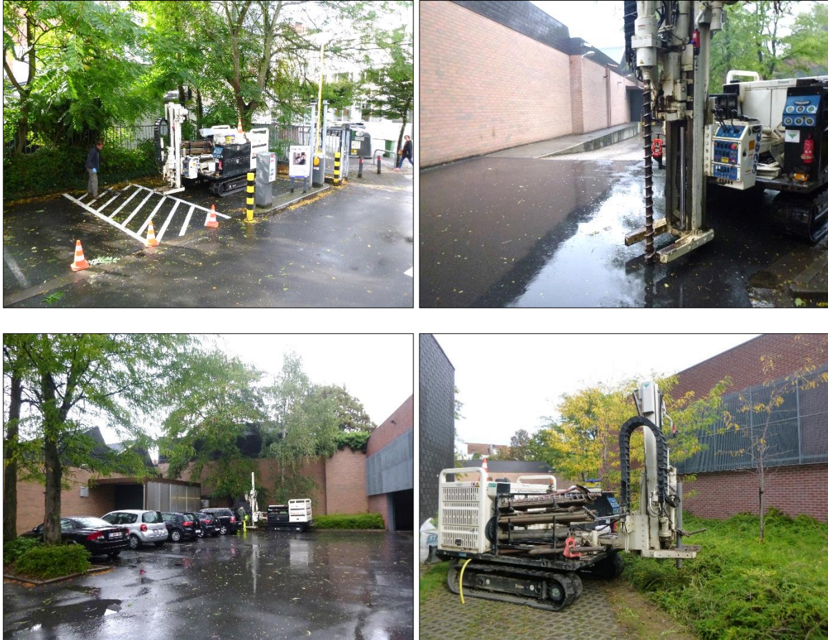
Foto 2: Uitvoeren van de boringen – 1 (links boven), 2 (rechts boven), 3 (links beneden), 4 (rechts beneden) (©BAAC)
