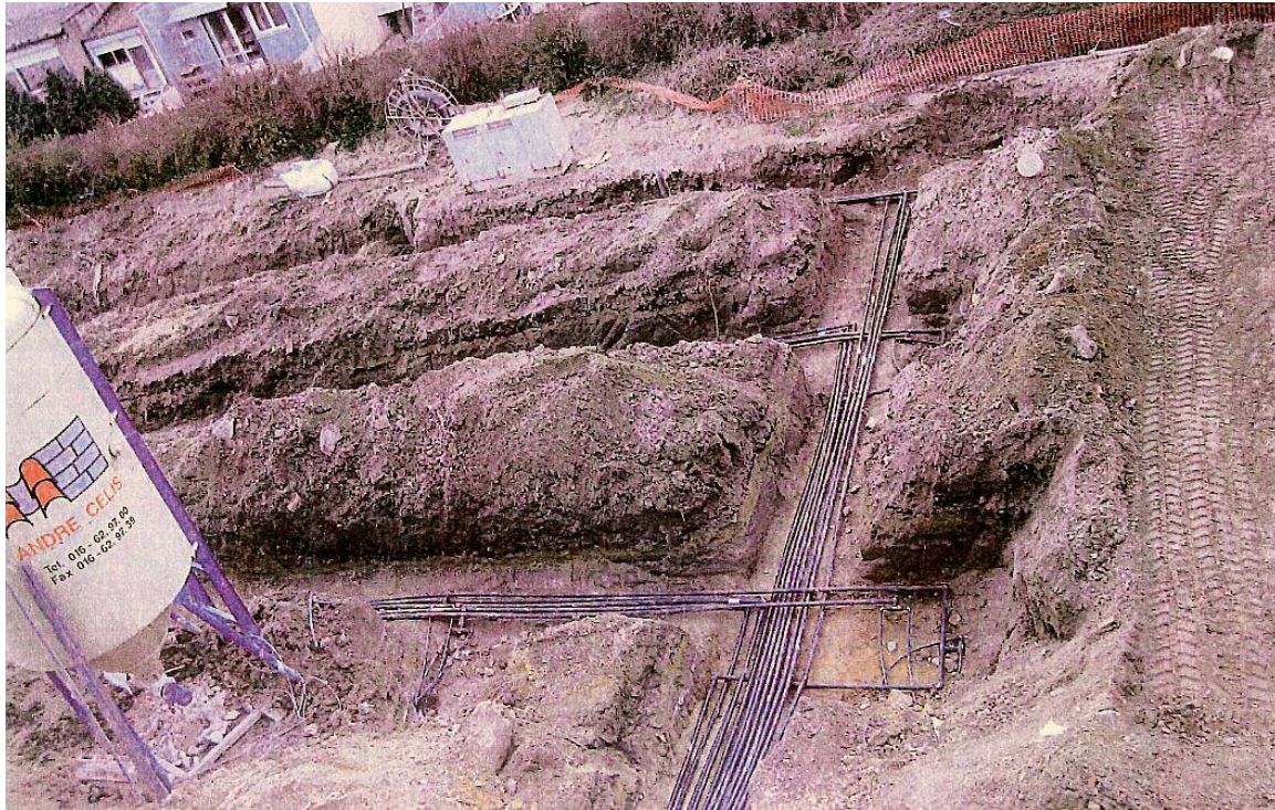
Figuur 32. Voorbeeld van de intensieve bodemingrepen die gepaard gaan met de aanleg van een BEO-veld (© AKZO NOBEL). In het geval van de Parksit zal er niet met sleuven gewerkt worden, maar wordt het volledige terrein vlakdekkend afgegraven tot op een aanzienlijke diepte.
