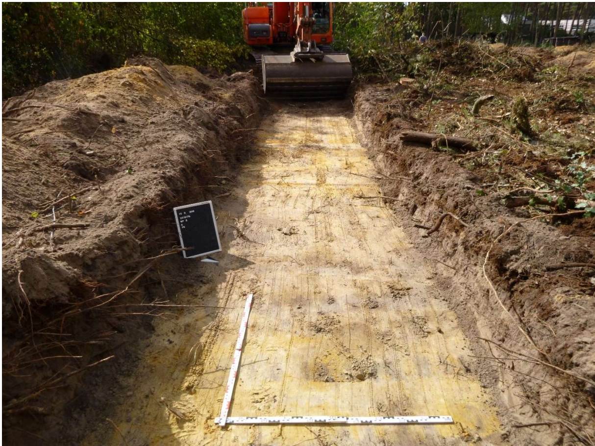
Figuur 8. Zicht op het aanleggen van proefsleuf 5. ©LARES
