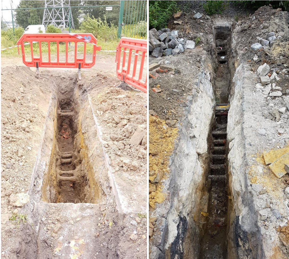
Foto 1: Huidige toestand kabels en leidingen (links: Sleuf 6c; rechts: Sleuf 12b)
