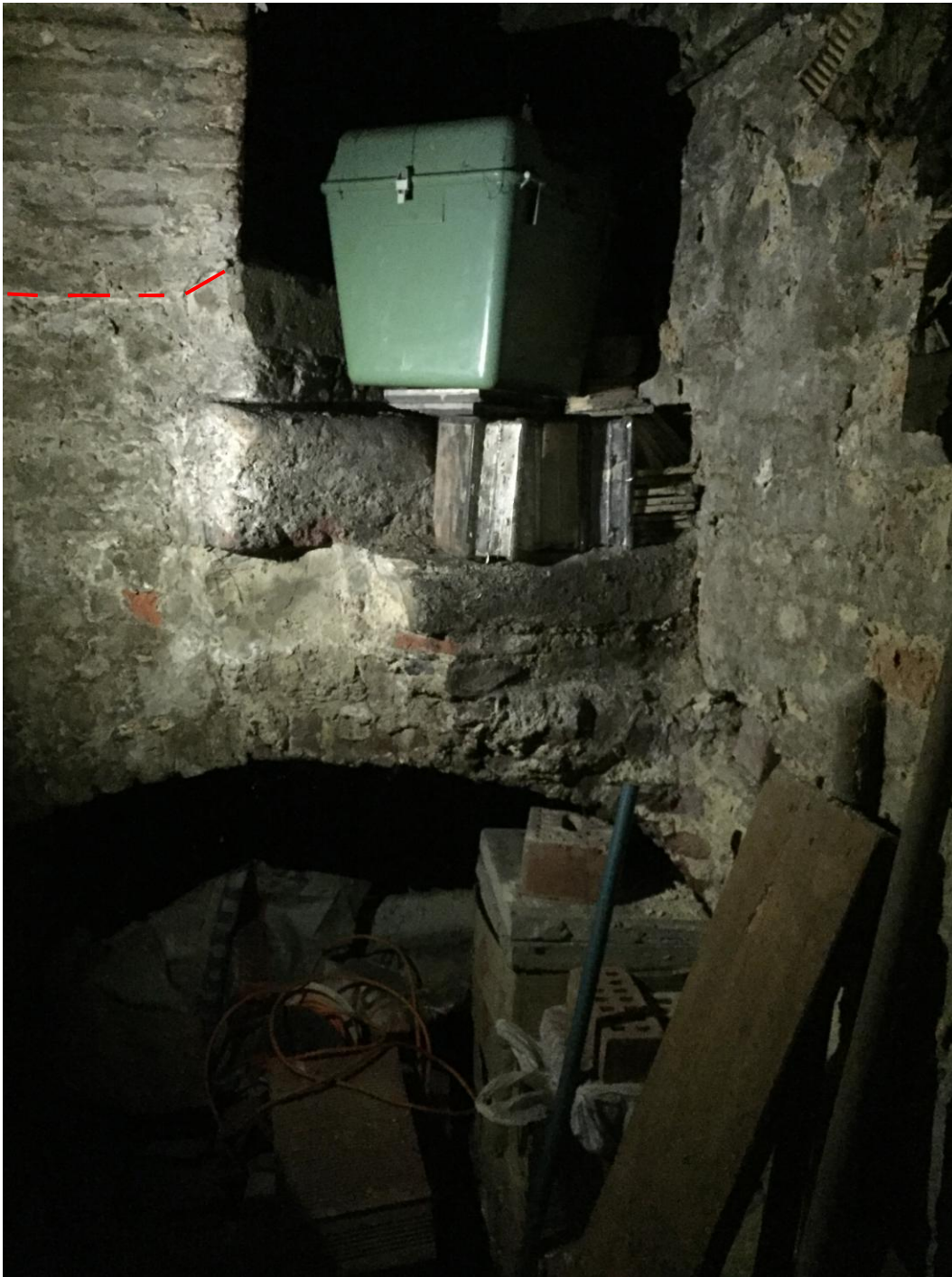
Afb. 53. Foto van de wenteltrap van de kelder binnen Tiensestraat 195. Bij de rode stippellijn bevindt zich een bouwnaad, hier is de oude trap 'afgekap'.
