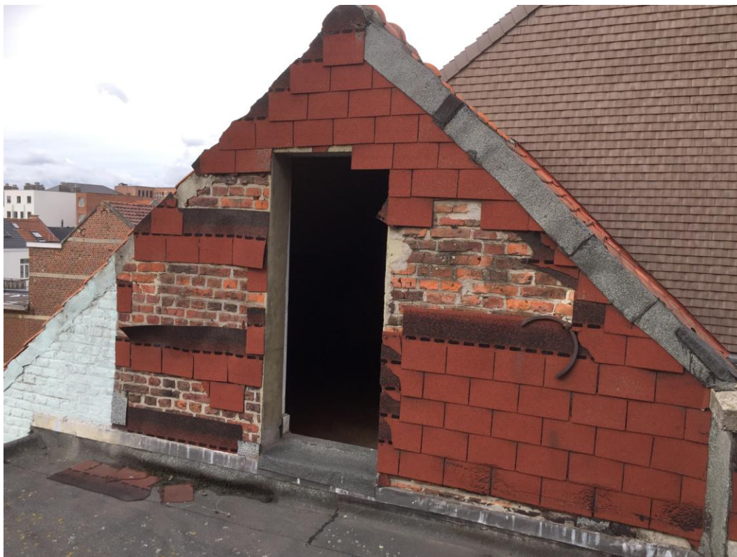
Afb. 57. Foto van het dak en de zolder binnen Tiensestraat 195.
