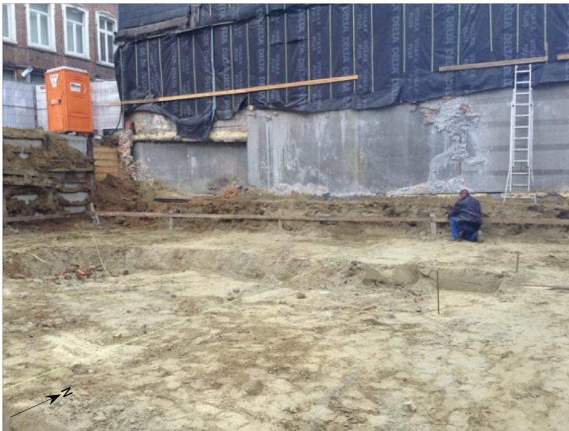
Afb. 49. De uitgraving van de parkeerkelder in 2013 op het naastliggende perceel, ten westen van het plangebied.
