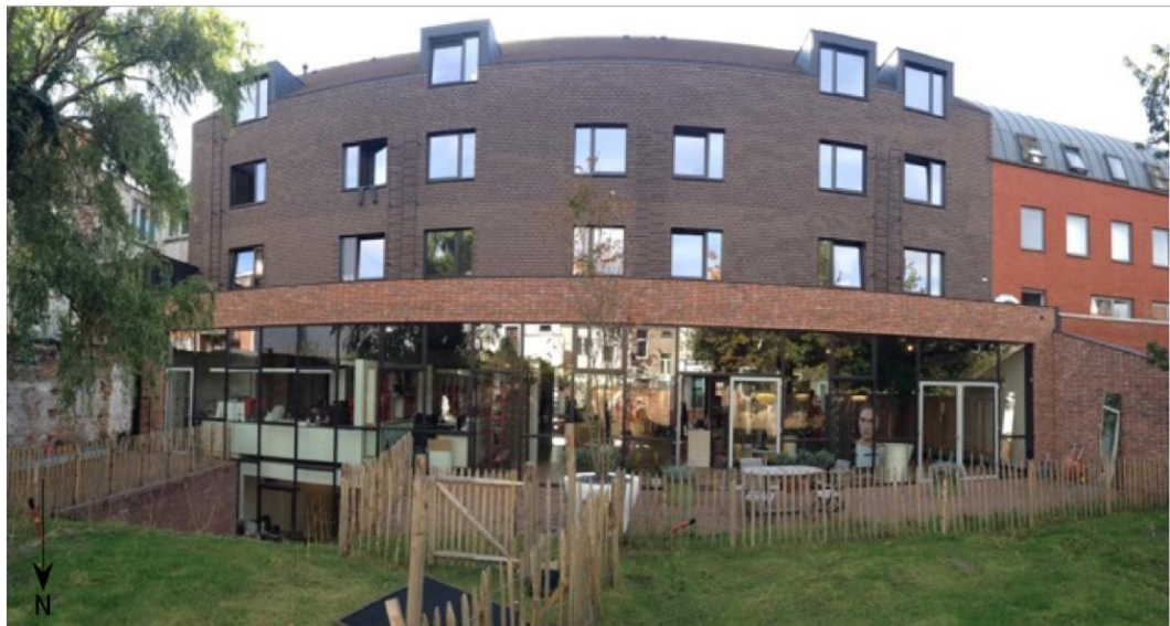
Afb. 11. Achterzijde van de gebouwen op percelen 381E, 382F en 384G.
