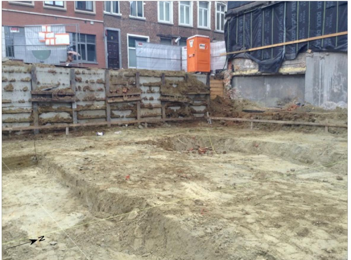
Afb. 48. De uitgraving van de parkeerkelder in 2013 op het naastliggende perceel, ten westen van het plangebied.
