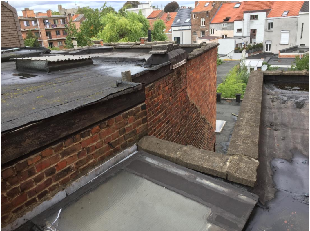
Afb. 59. Foto van de dakconstructie van Tiensestraat 197.
