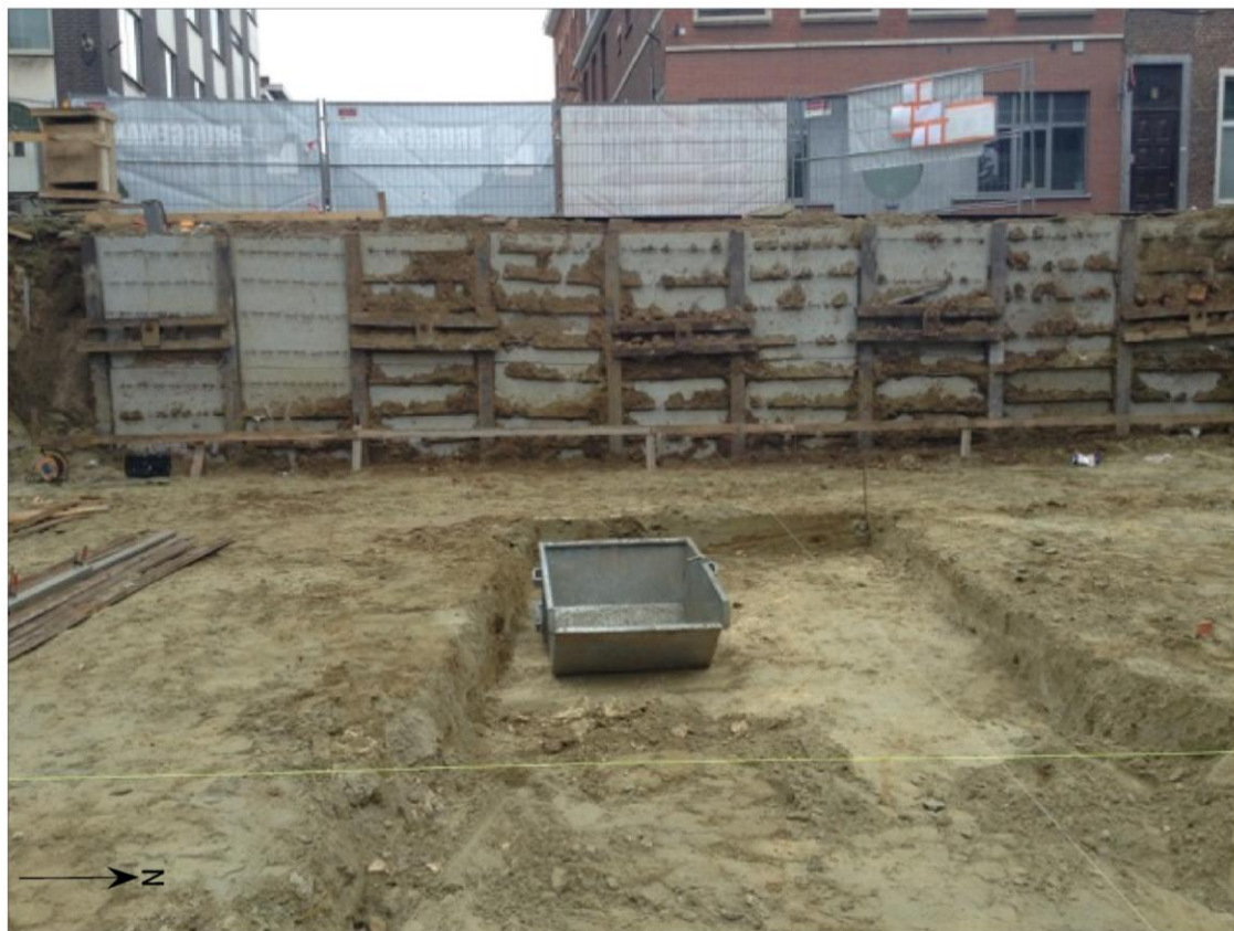
Afb. 47. De uitgraving van de parkeerkelder in 2013 binnen het plangebied.
