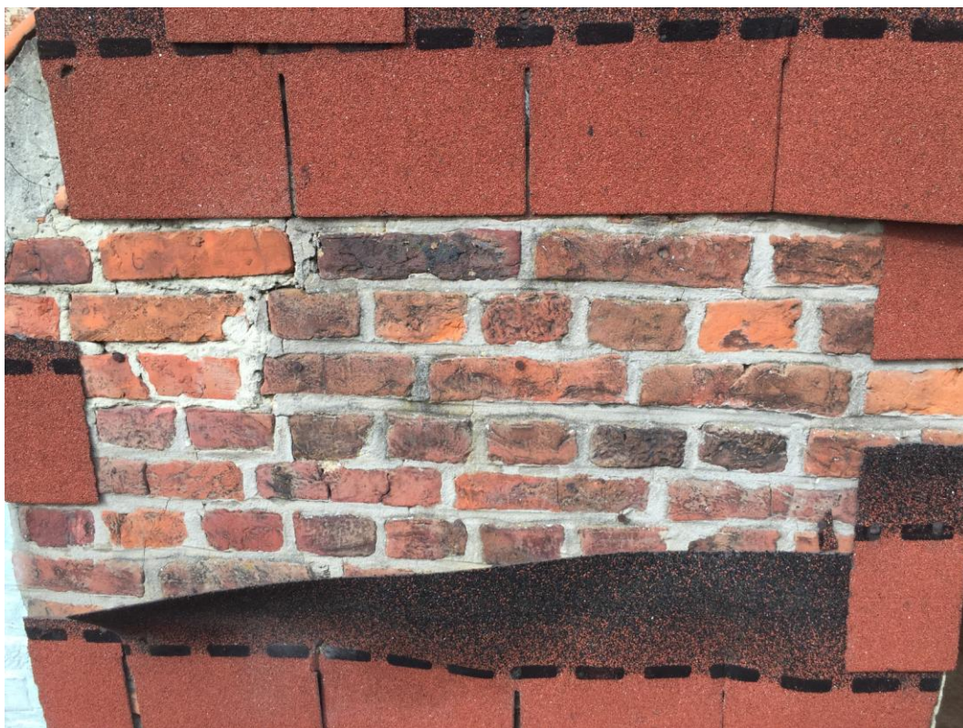
Afb. 58. Detailfoto van het dak en de zolder binnen Tiensestraat 195.
