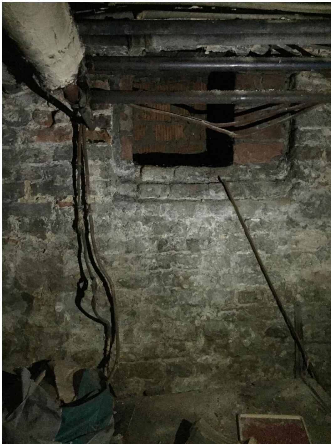
Afb. 55. Detailfoto van luchtgat van de kelder binnen Tiensestraat 195.
