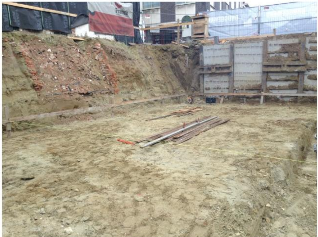
Afb. 46. De uitgraving van de parkeerkelder in 2013 binnen het plangebied. Het puinspoor in het zuidprofiel is het restant van de kelder van de toenmalige gesloopte bebouwing.
