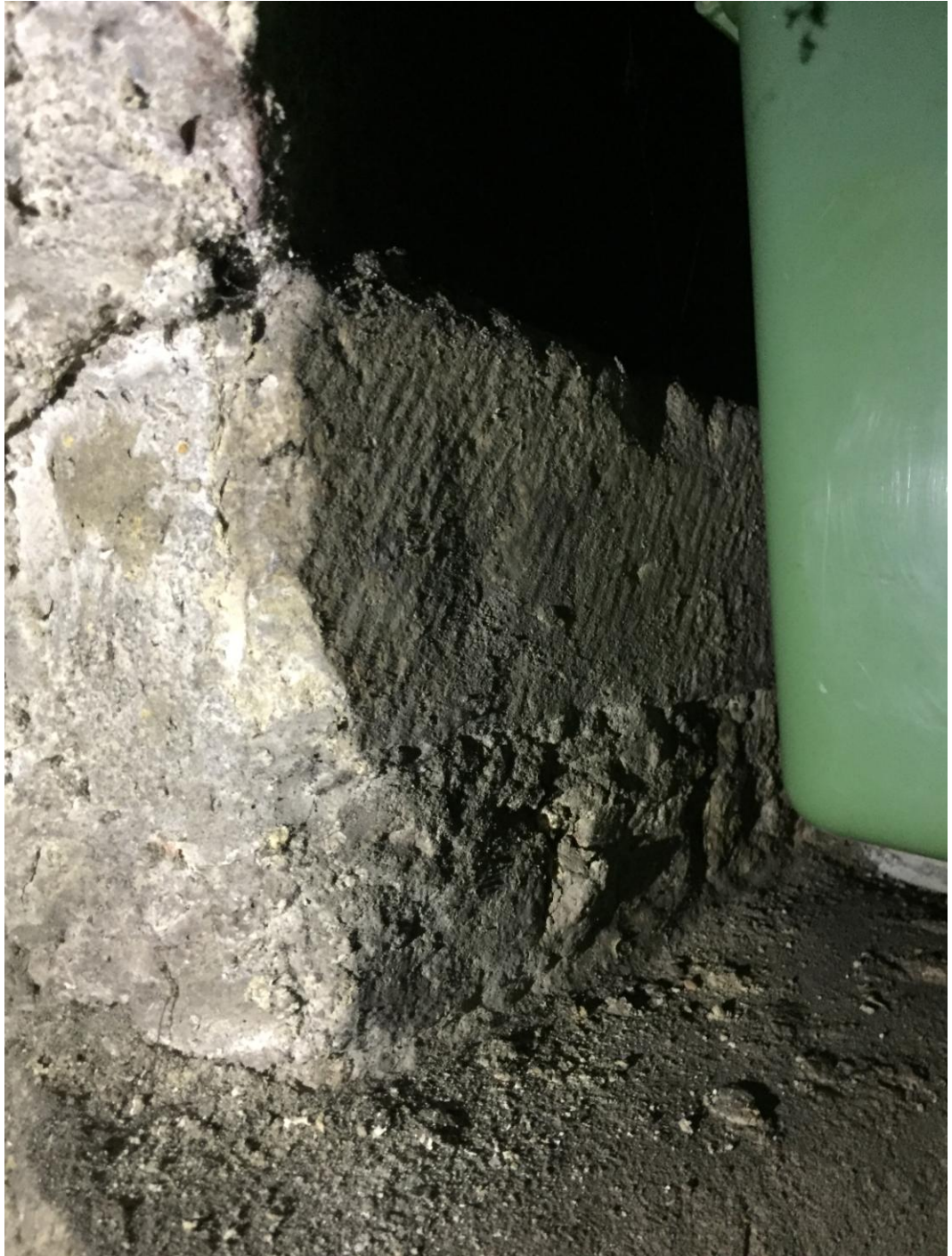
Afb. 54. Detailfoto van de wenteltrap van de kelder binnen Tiensestraat 195. Te zien is een deel van een natuurstenen trede met scharrering (de schuine groeven in de steen).
