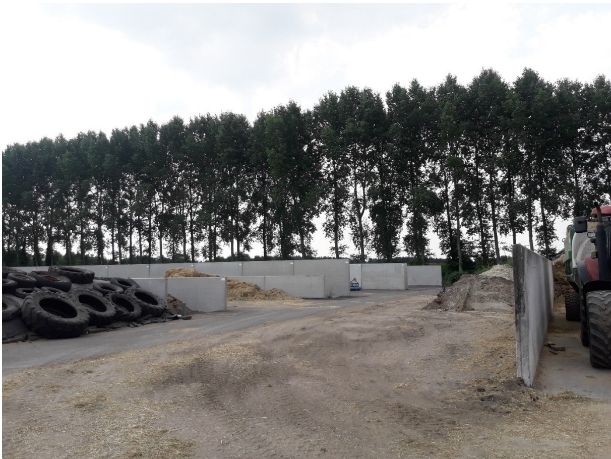
Figuur 3: Zicht op de reeds aangelegde sleufsilo's vanuit het noordwesten
