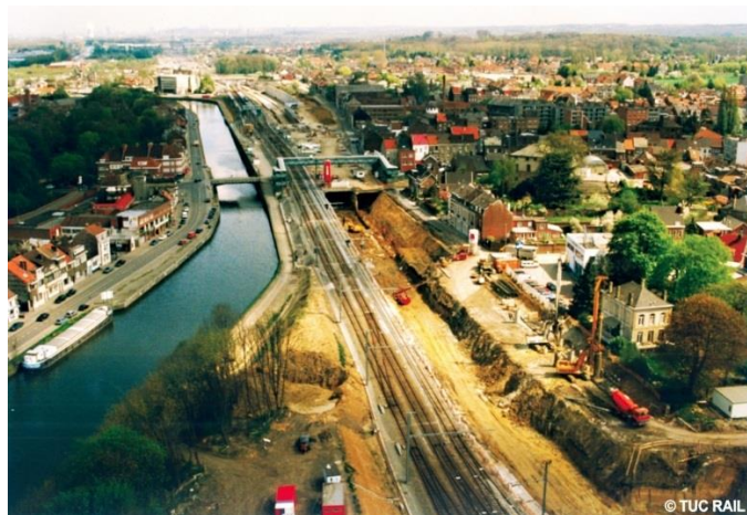
Figuur 4: Foto van de aanleg van de HSL 5
