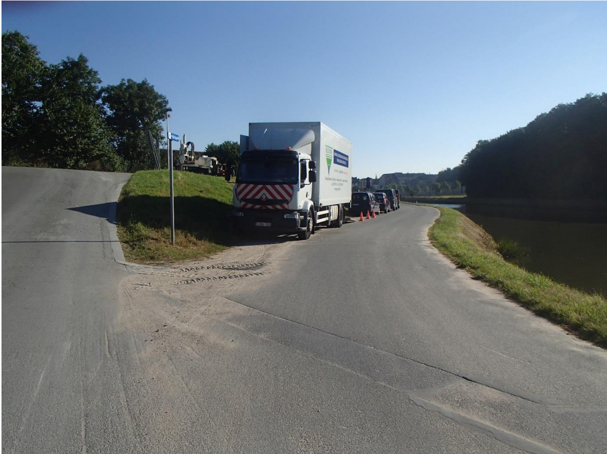
Figuur 1: Foto van het de uitvoering van de werkzaamheden.
