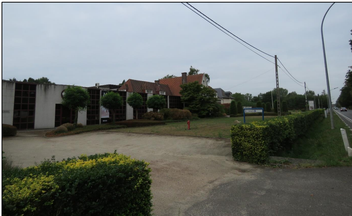
Figuur 2 Zicht vanop de Liersesteenweg op de fabrieksgebouwen in de oostelijke hoek van het terrein.
