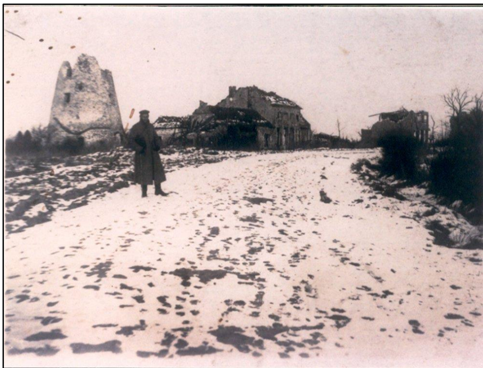
Figuur 35: Zicht op de in WO I beschadigde stenen molen Van Parijs (" Steene molen " naast het onderzoeksgebied). De vernielingen uit de oorlog zijn duidelijk zichtbaar op deze foto (Westhoekverbeeld.be, 2018).
