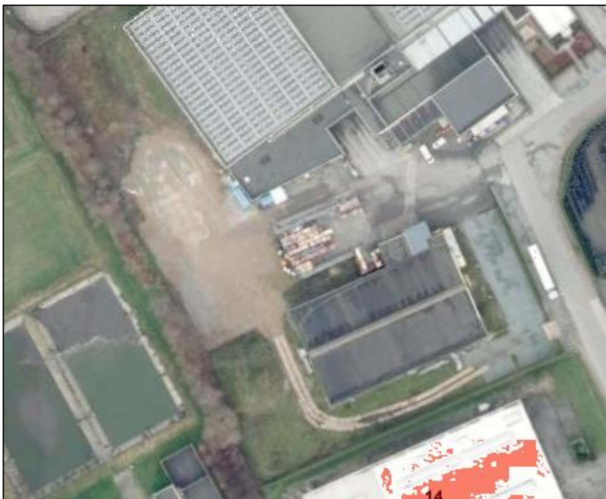
Figuur 24 Detail van het zuidelijke deel van het plangebied op de luchtfoto van winter 2014 (bron: geopunt.be). De grondwerken voor de aanleg van de windturbine zijn in volle gang. De onverharde zone in het zuiden wordt gebruikt als toegangsweg voor de werken, ook de nutsleidingen voor de turbine zijn hier gelegen.
