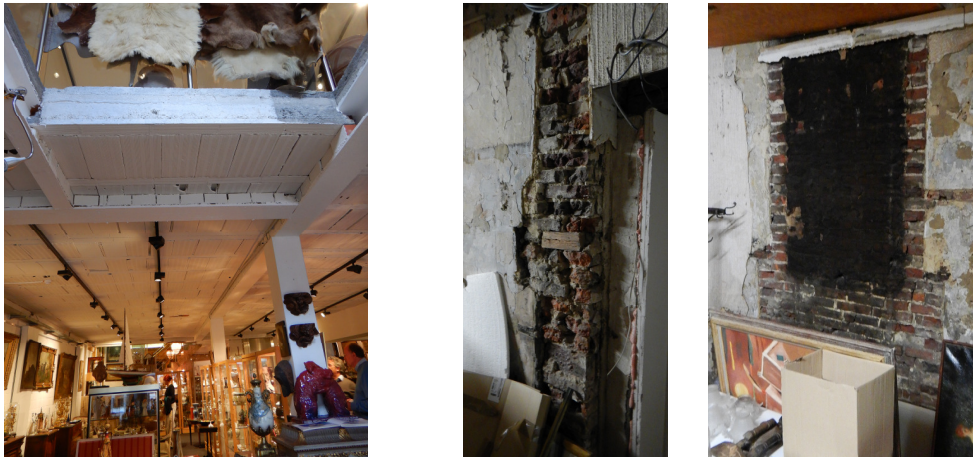
Figuur 13. De stalen balken in het veilinghuis (links) en de resten van 19 e -eeuws muurwerk in nummer 67 (rechts).
