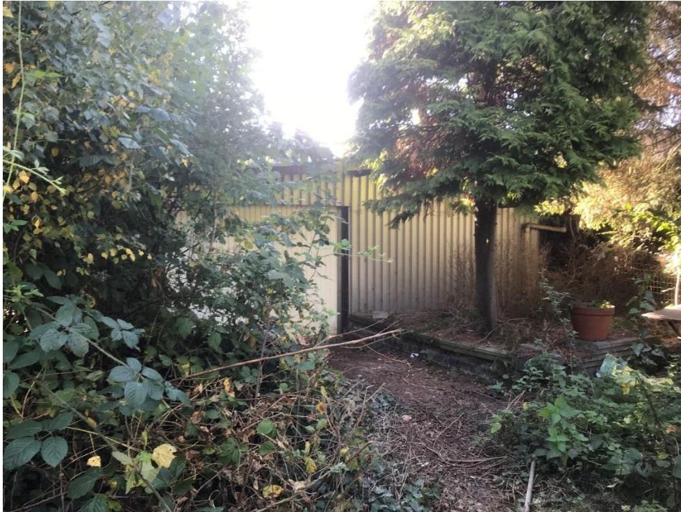
Figuur 6: Zicht op de achterzijde van de garagebox. 8
