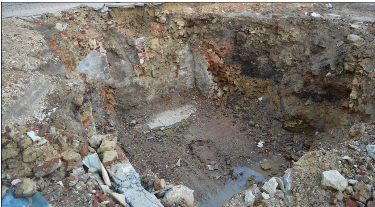
Afb. 14: Overzichtsfoto van een kelder, die zich aan de Graethemstraat situeerde (Bron: Aron bvba, dd. 26/09/2018, 20181248).
