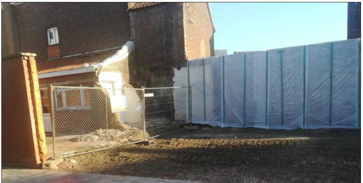
Figuur 25: Huidige toestand terrein, rechts locatie reeds gesloopt volume (bron: opdrachtgever).
