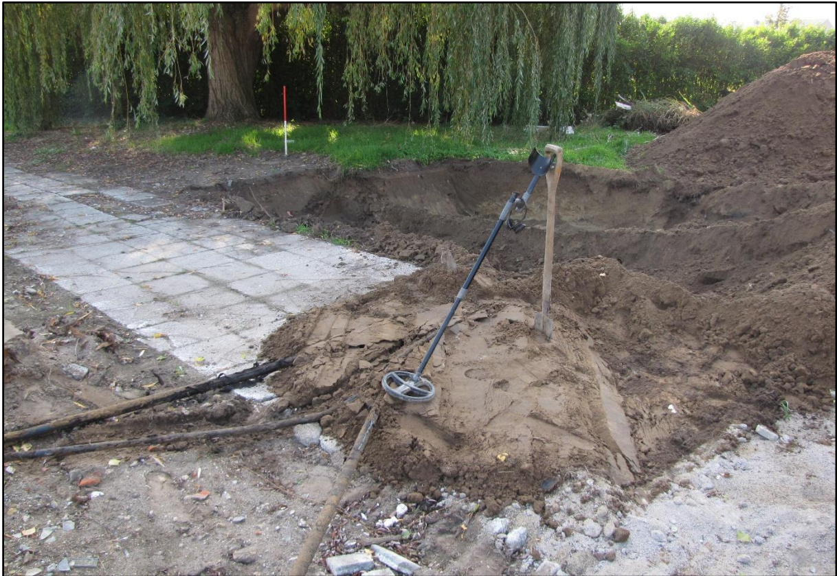
Figuur 7 Zone van een mazouttank in het uiterste zuidwesten van het plangebied.
