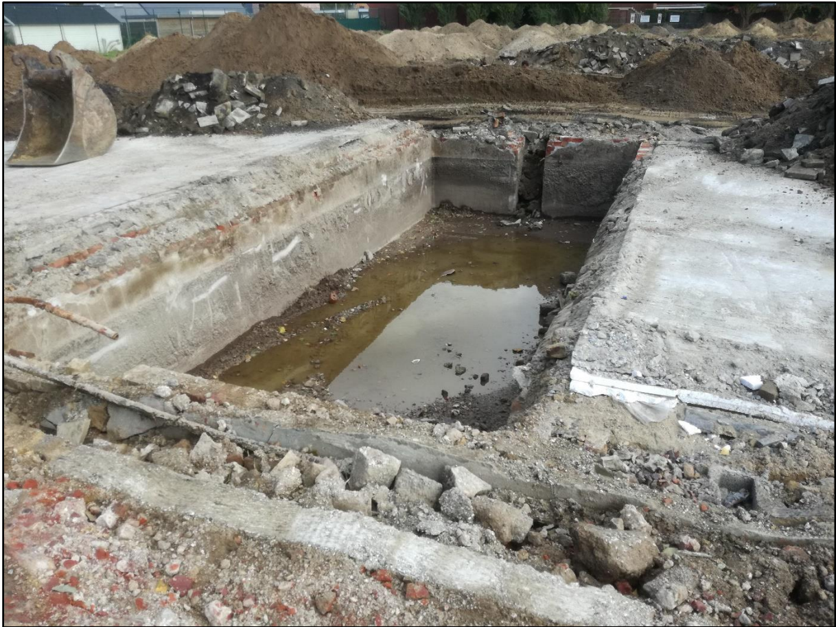
Figuur 3 Zicht op een kelder in het noordelijke deel van het voormalige schoolgebouw. De muurfunderingen werden conform het programma van maatregelen van de bureaustudie behouden.
