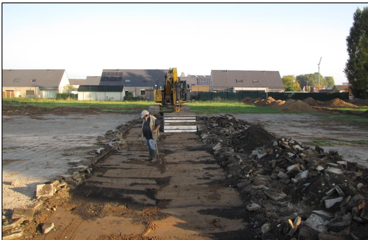
Figuur 14 Metaaldetectie na het verwijderen van de dals (speelplaats).
