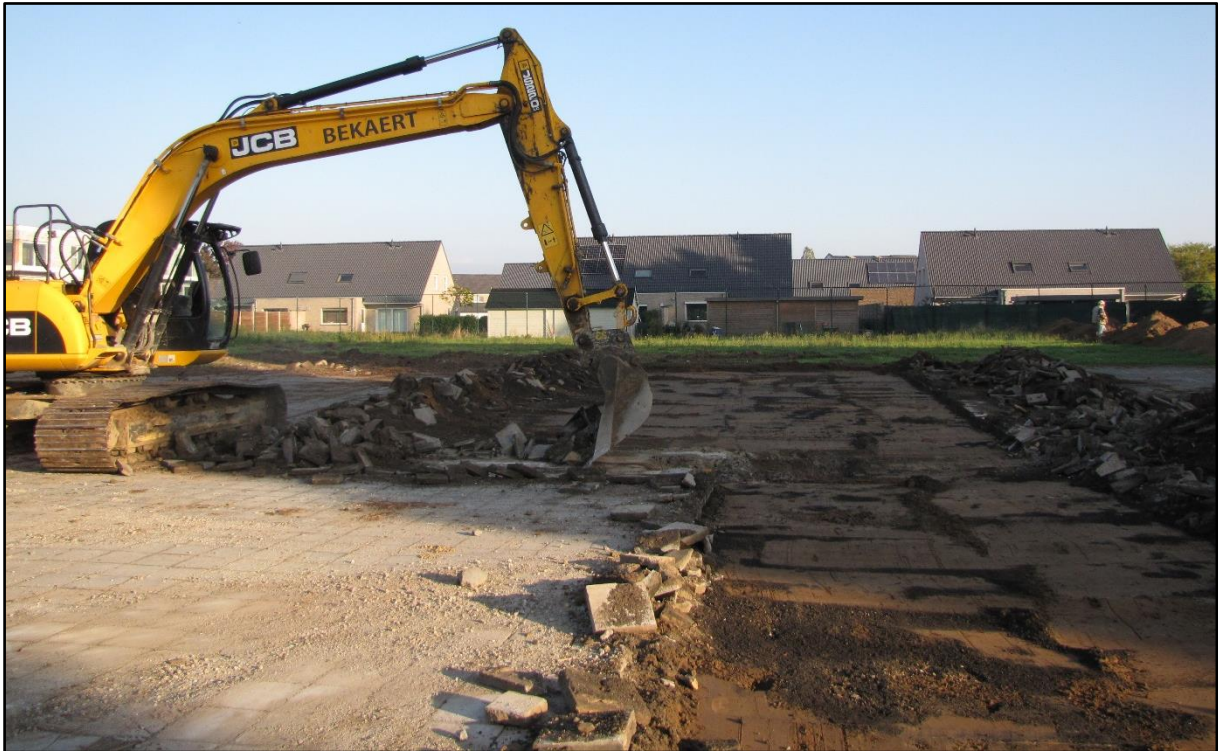
Figuur 5 Verwijderen van de dals tijdens het vooronderzoek en ter hoogte van de sleuven.
