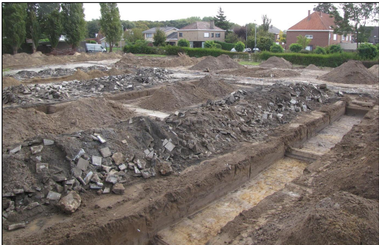
Figuur 10 Sfeerbeeld tijdens de aanleg van de sleuven.
