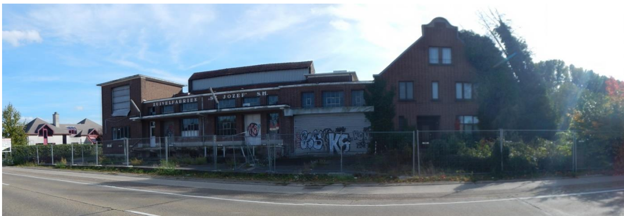
Fig. 5: zicht op de af te breken voormalige zuivelfabriek en woning aan de Maaseikerlaan 28
